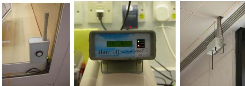
圖 3 香港文化館建置無線溫溼度監測系統(左、中圖)及訊號加強用的強波器(右圖)。
