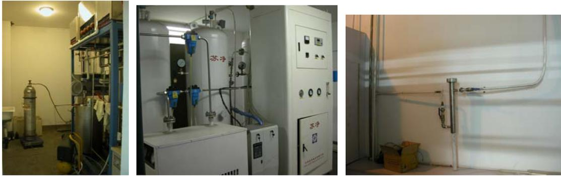
圖 7 上海博物館消毒間設有大小兩座消毒櫃（上排左），上排右圖多功能滅菌器 1 的左側房間即是環氧乙烷與溴化甲烷生成室（下排左），上排右圖左側樓梯上去二樓是氮氣處理設備，左側是控制室，右側是氮氣生成設備（下排中）；氮氣生成並調濕之後在進入多功能滅菌器之前，還加設有可加注藥物的連管（下排右）。
