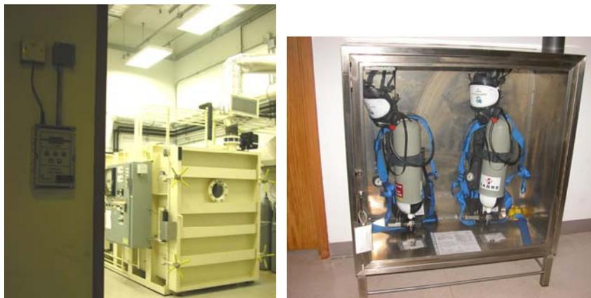
圖 2 香港文化館的氮氣除蟲櫃（左圖）；處理室外特設有氧氣濃度監測儀及氧氣筒（右圖）。
