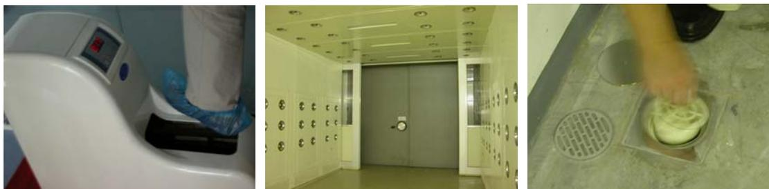
圖 13 北京首都博物館修復室及科學儀器室入口處設有鞋套機(左圖);地下庫房入口的風淋通道(中圖);防蟲設計的落水孔(右圖)。
