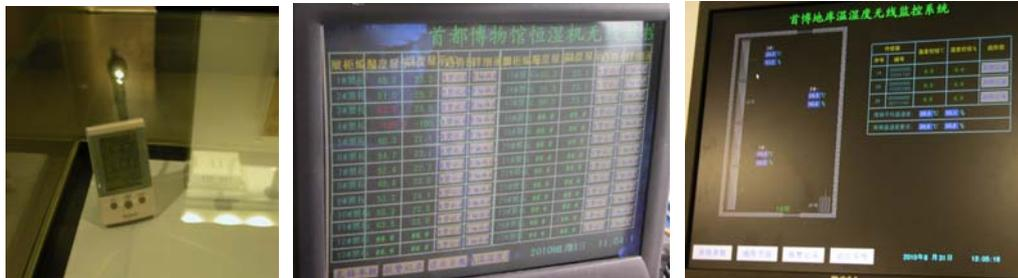
圖 11 北京首都博物館 2008 年建置的無線網路溫溼度監測系統軟硬體設備。
