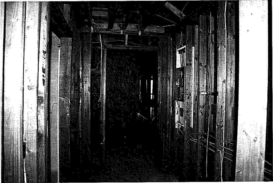
正建造中的木建築與各管線、構件之組合(1)
