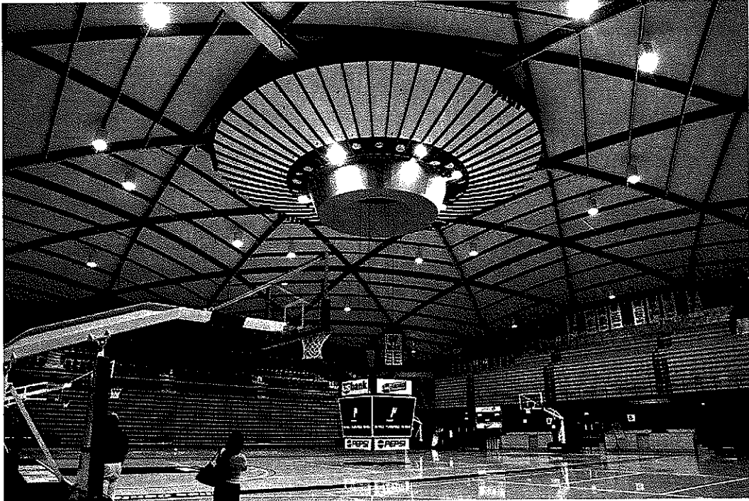
Portland 大學 Chile 中心之大木構運動場館
