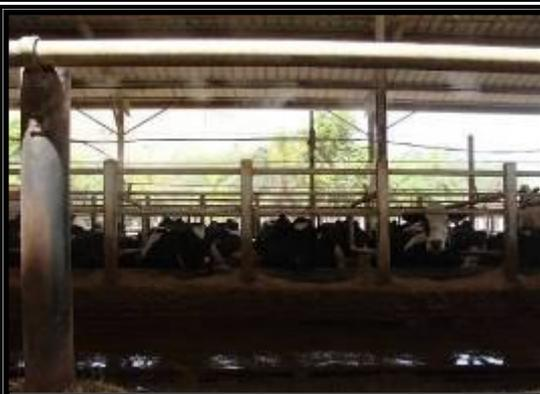
圖 19. 牛舍噴霧降溫系統
