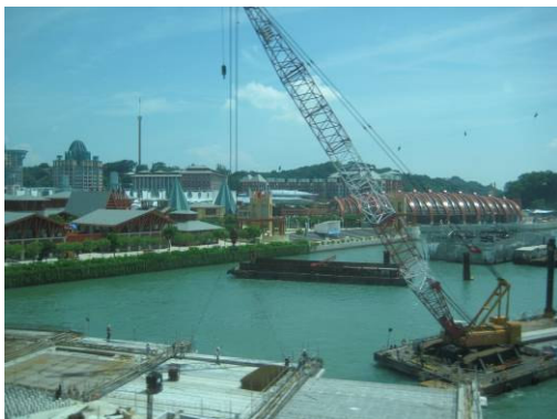
施工中的海洋生物園區
