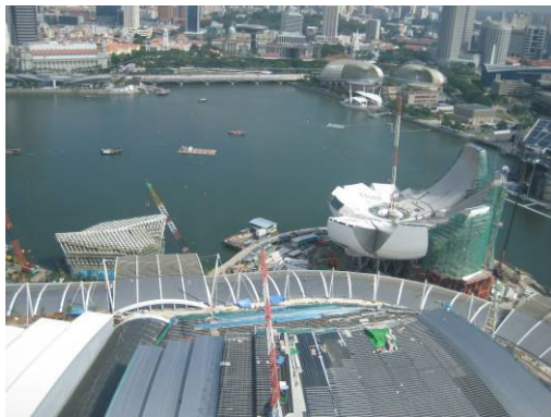
施工中的水晶宮及博物館
