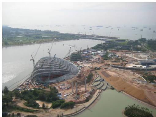
濱海堤壩及施工中的熱帶植物園
