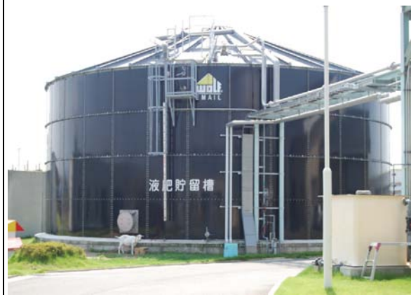
農村資源回收利用處理後之液肥貯留槽，液肥免費提供農民使用
