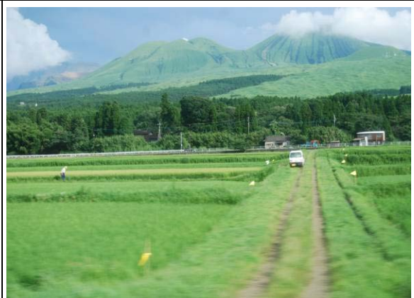
農地重劃區之農路為土路，除車道外， 餘自然長草，含兩側水路之邊坡
