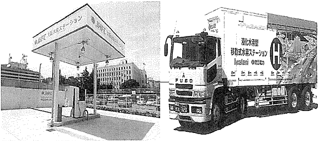
圖 4 燃料電池車輛加氣站及移動式加氣站
