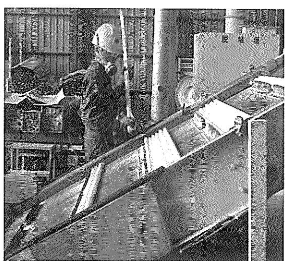
廢照明光源進料處理情形
