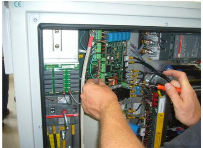
圖 24 以一手動開關模擬空橋連鎖訊號
