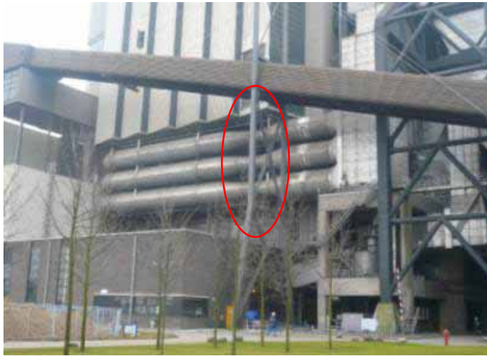
如圖示為鍋爐本體及二次風管段的 Venturis，在其喉部內各埋設有 PRPMECON 的感測器 McON Air。
