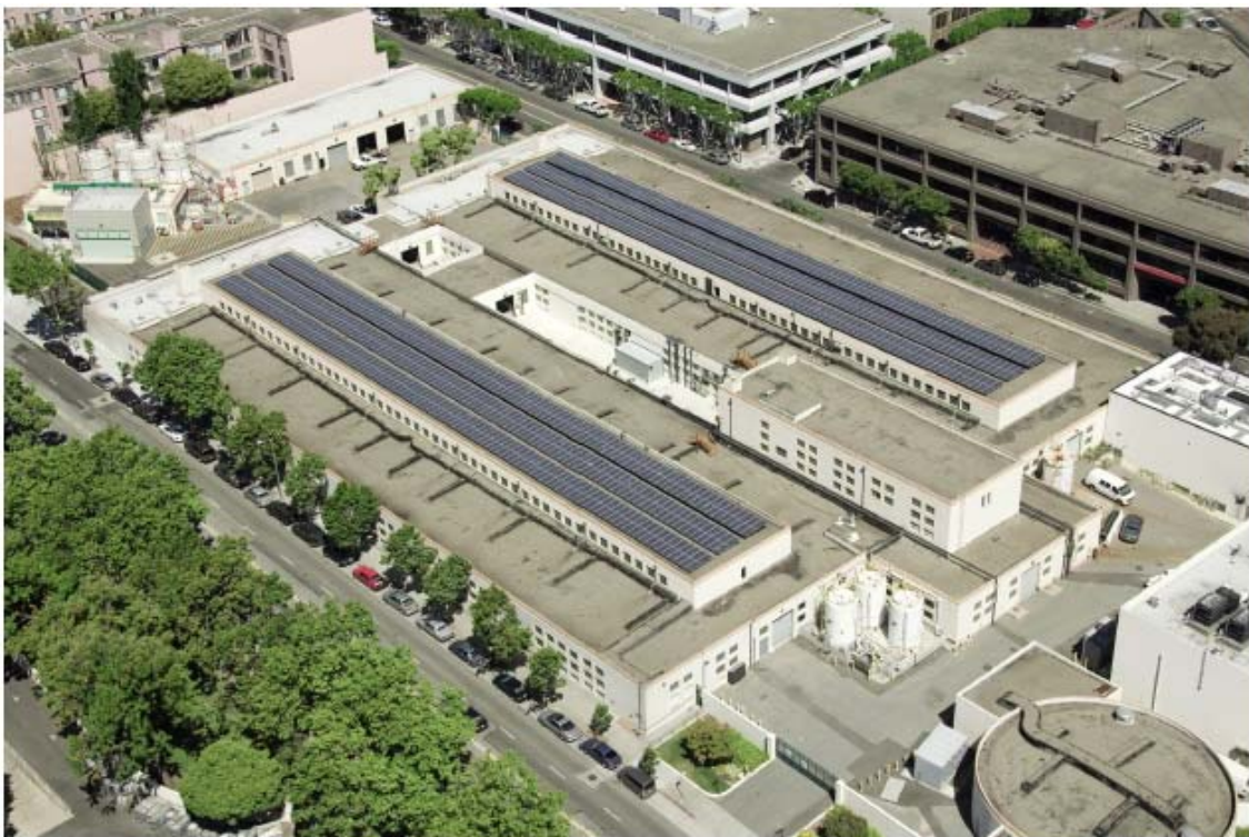
圖 4.7.1 太陽電池實際上裝設情形
