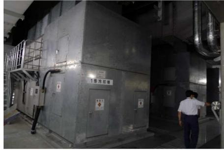
圖三十六 因地面層屋突空間有限，冷卻水塔設置於地下 3 樓
