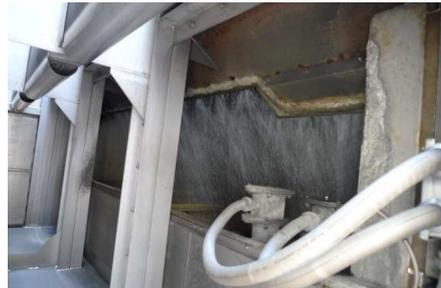
圖五十七 冷卻水塔內部水瀑冷卻及吸音裝置照片
