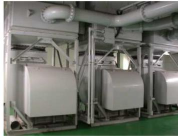
圖四十二 世貿變電所主變壓器室鼓風機
