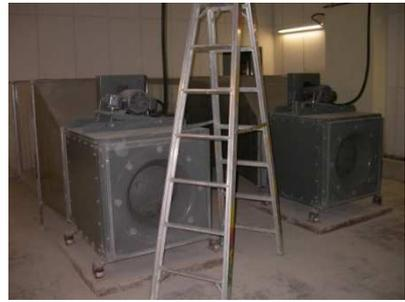
圖四十六 排風機室設置吸音板照片
