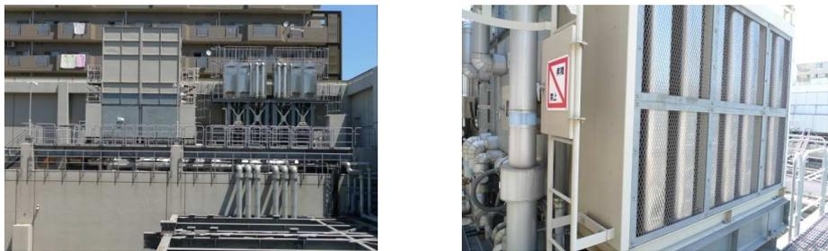
圖二十七 地面層 3 樓露臺設置變壓器冷卻用冷卻水塔及補給水槽
