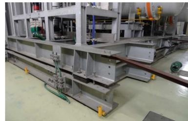
圖五十八 275kV GIS 防振台架照片
