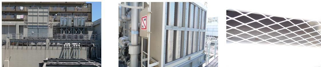
圖五十二 冷卻水塔暨吸音裝置照片
