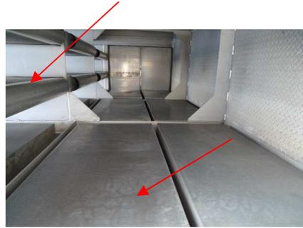
圖五十六 冷卻水塔進風處吸音設施
