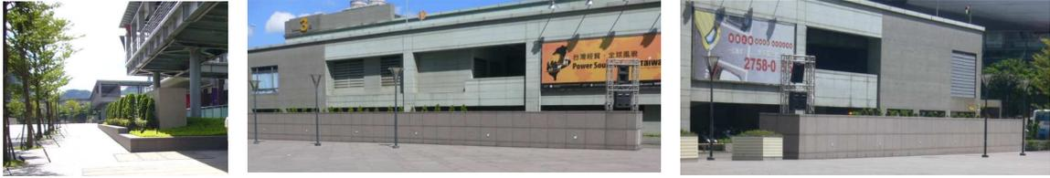
圖二十四 世貿變電所地面層進排風口屋突圍牆高約 2 公尺
