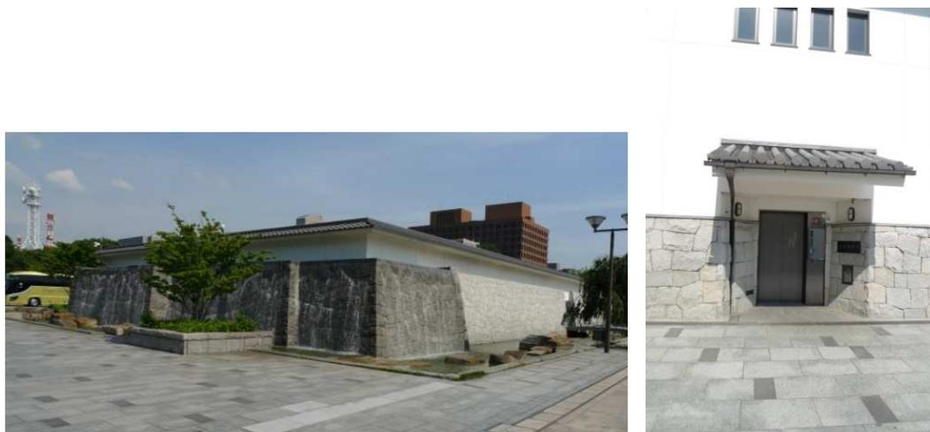
圖二十 左為變壓器冷卻用水塔用之補給水槽屋突設施，規劃設計水瀑及池塘，不僅與周邊景觀融合協調，更巧妙的掩蓋地下建物必要之通風等噪音，右則為變電所人員進出電梯。
