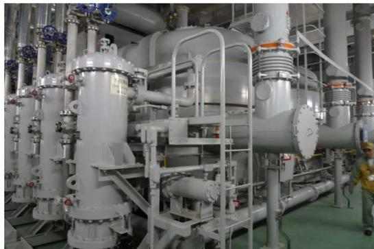
圖三十四 變壓器照片，左側為熱交換設施
