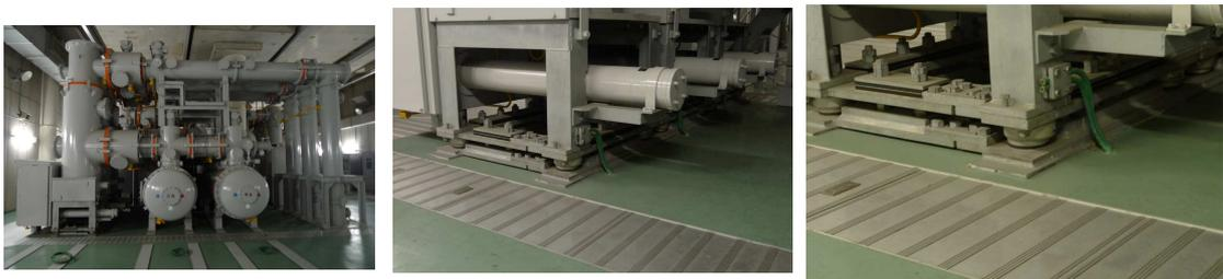
圖六十五 275kV GIS 防振墊片照片
