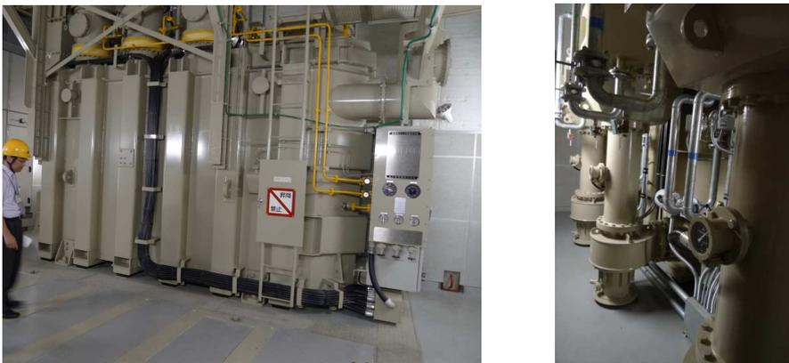
圖二十六 154kV/6.6kV 30MVA GIT 與熱交換設施
