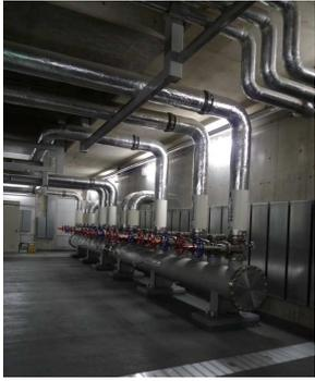
圖三十五 冷熱水管 Pump 室
