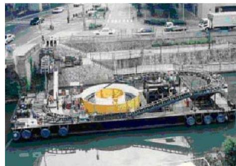
圖十六 載運 1,800 公尺長尺電纜台船
