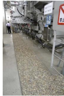
圖十四 變壓器排油溝
