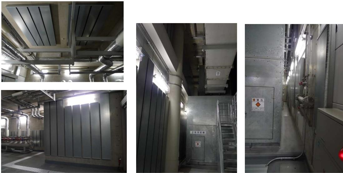
圖六十四 冷卻水塔室牆面及頂板設置吸音板照片
