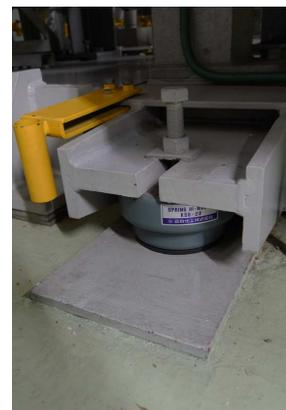
圖五十九 154kV GIS 防振墊片照片
