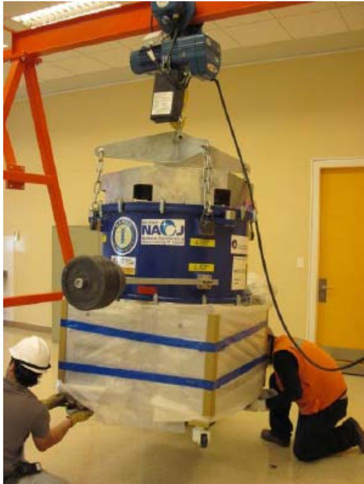
圖 16 吊起接收機安裝四個輪子
