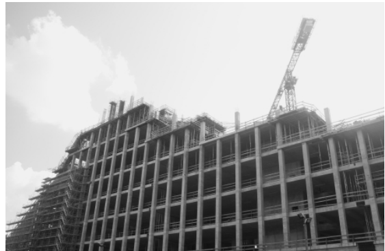
拉國國家圖書館新建工程
