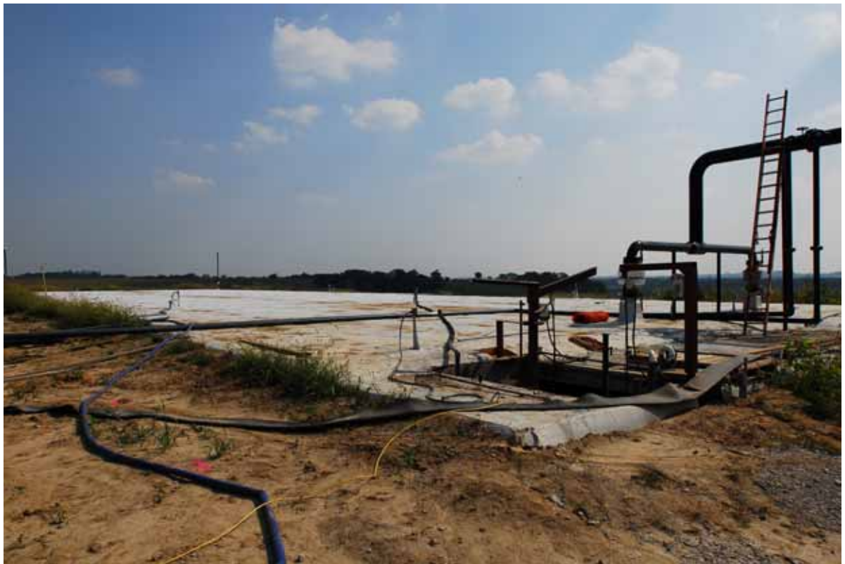
照片 6. 愛荷華州立大學土木環工系畜牧廢棄物厭氧消化槽 (field-scale)
