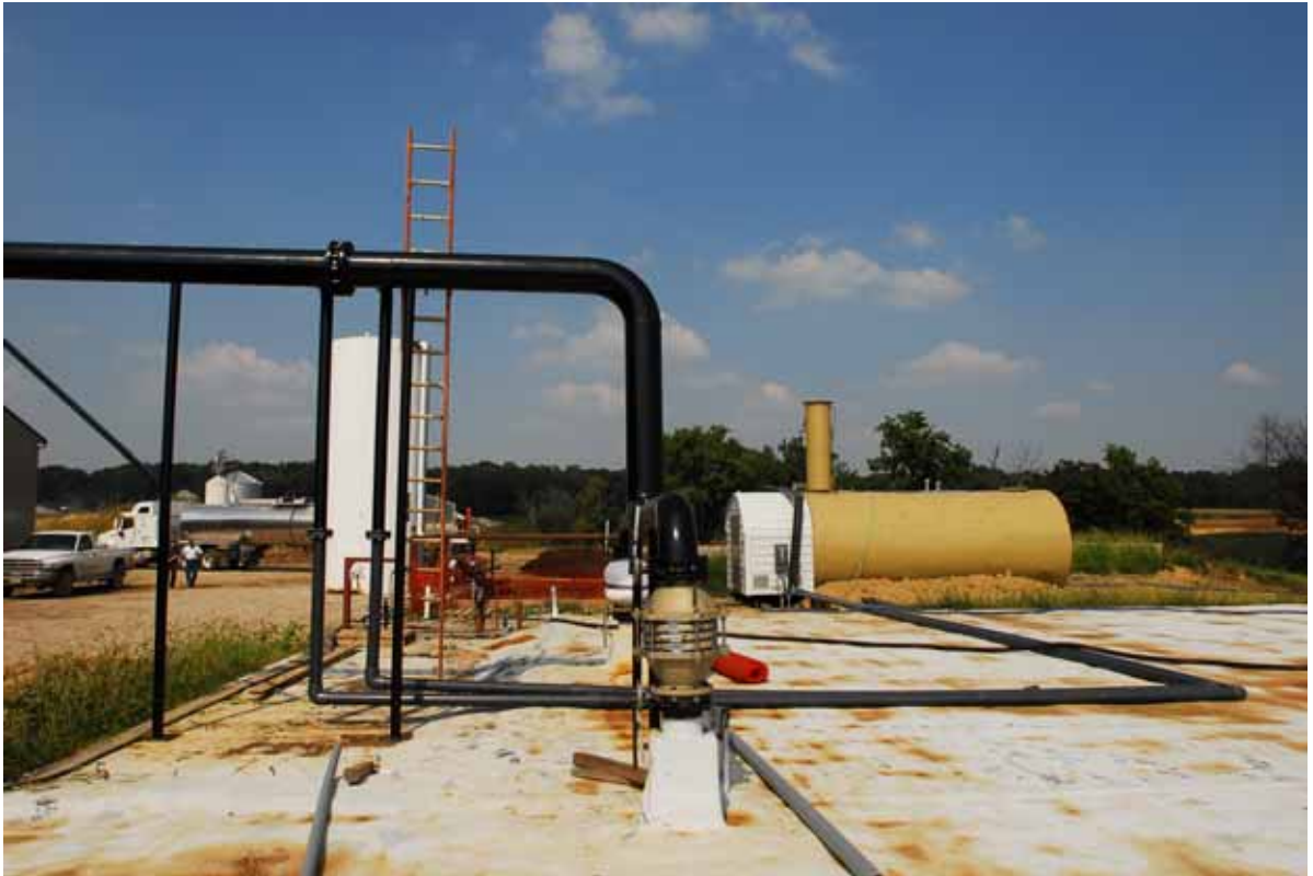
照片 7. 愛荷華州立大學土木環工系畜牧廢棄物厭氧消化槽之廢氣回收處理系統 (field-scale)
