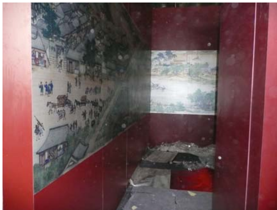
圖 5：展區內部布幕施工完畢
