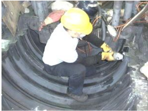
高中壓內缸下半整理
