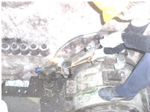
高壓外缸接合面間隙核測(拆卸前)
