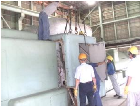
低壓內部導流板拆卸
