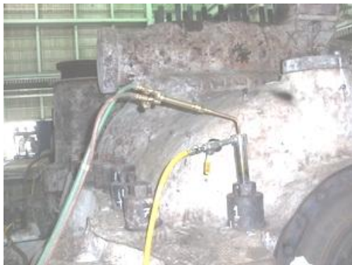
高壓外缸螺絲拆卸
