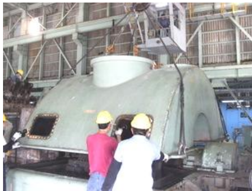
低壓外缸螺絲拆卸
