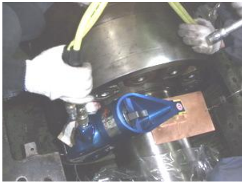
高壓外缸螺絲拆卸
