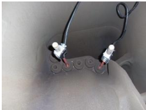
低壓外缸螺絲拆卸
