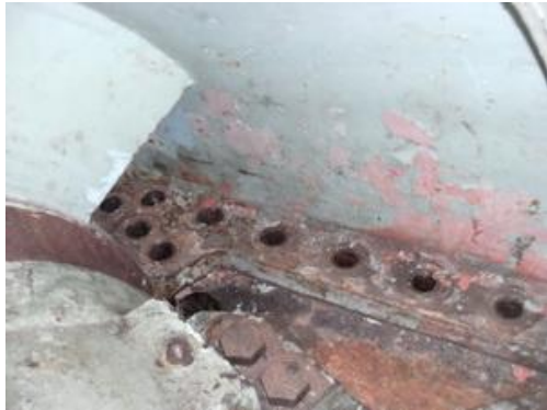
高壓汽機端外格蘭汽封
