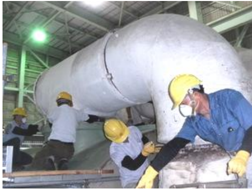
跨管拆卸吊出
