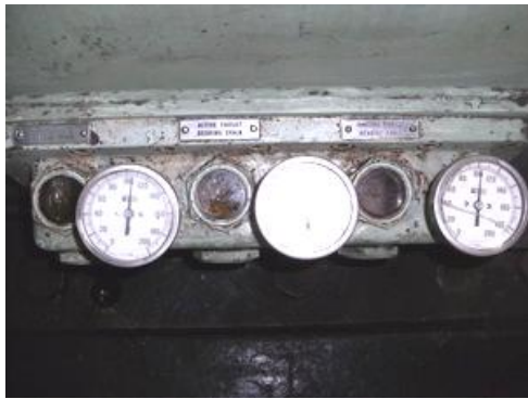
推力軸承回油視窗(active)
