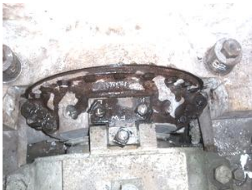
高壓外缸內部螺絲拆卸(右側)
