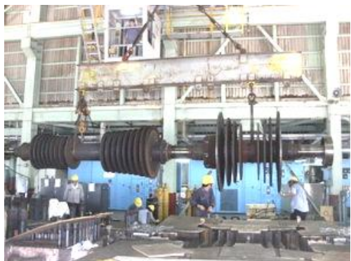
轉子吊出核測轉子下半間隙
