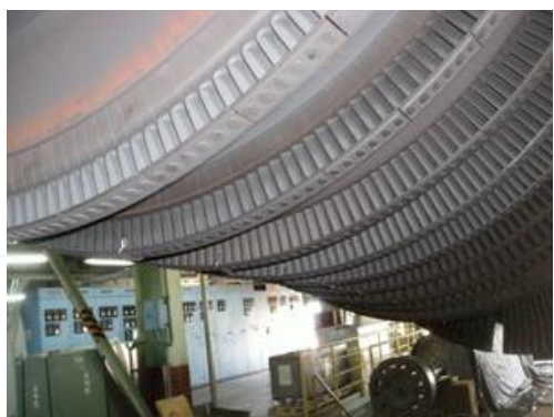
轉子吊出核測轉子下半間隙
