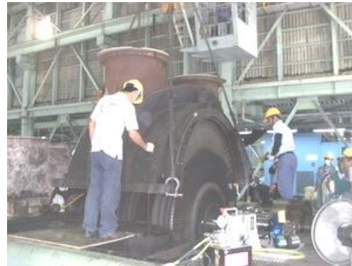
低壓內缸吊出
