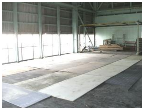
噴砂房鋪設合板保護樓地板
