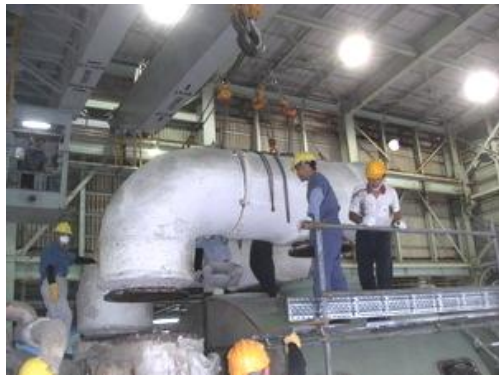
跨管拆卸吊出(右側)
