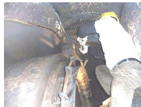
低壓內部導流板拆卸
