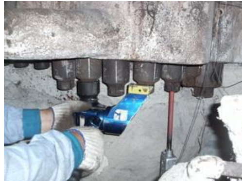
高壓進汽管法蘭螺絲拆卸
