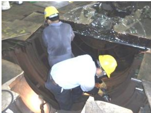
伍.1.2：拆卸靜葉環檢修汽封。
