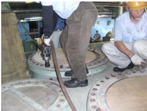
跨管接頭螺絲拆卸
