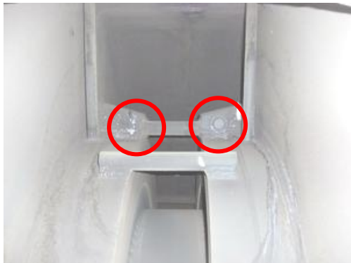
高壓 GE 端外格蘭螺絲拆卸
