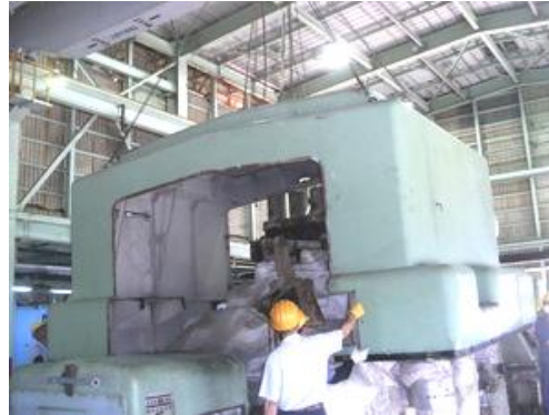
低壓內部導流板拆卸
