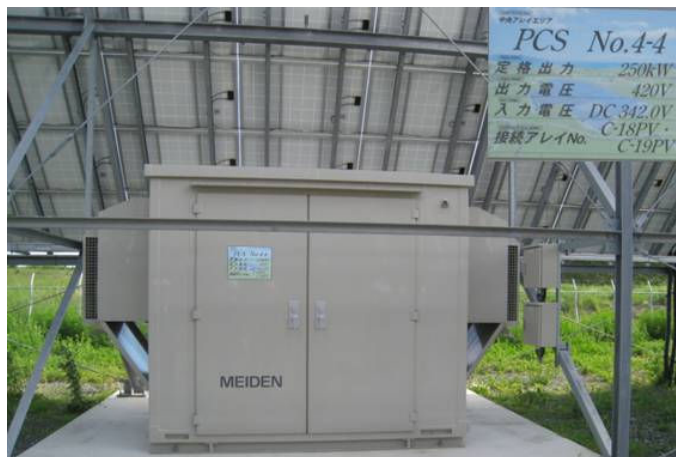
圖三十九：250kW 電力調控系統(MEIDEN 製造)
