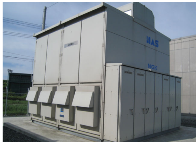
圖四十三：1000kW NAS 電池模組(NGK 製造)
