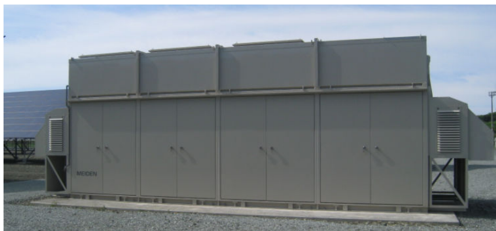
圖三十九：250kW 電力調控系統(MEIDEN 製造)
