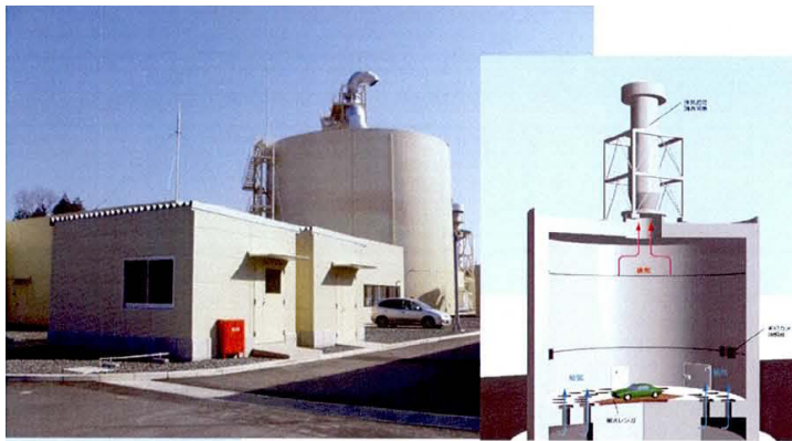
圖 24 耐爆火災試驗設備
