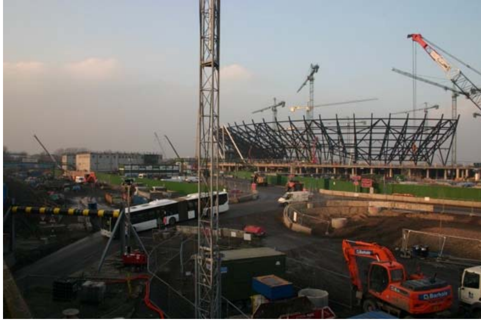
圖 14 污染場址 Olympic Park 建設現況
