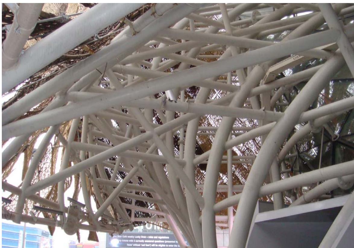
上海世界博覽會－西班牙館外部鋼結構
