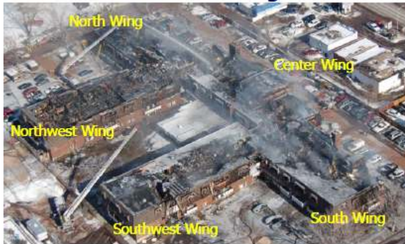
照片 38：鳥瞰整棟公寓西、西北、中間、南及西南 5 區之燃燒情形。
