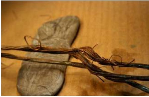
照片 30：在船尾較低層甲板上採集到之日光燈電源線上巨觀分析下發現有弧光受損現象。
