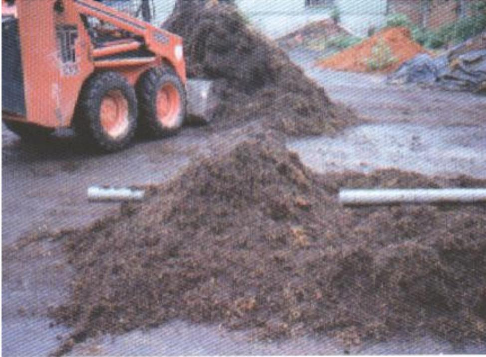
圖 30. 塑膠管埋入堆肥材料中
