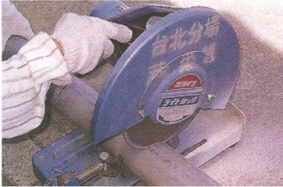
圖 28. 塑膠管鋸孔
