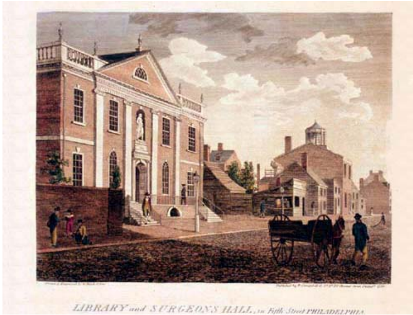
照片十 十八世紀 the Library Company 建築原貌
