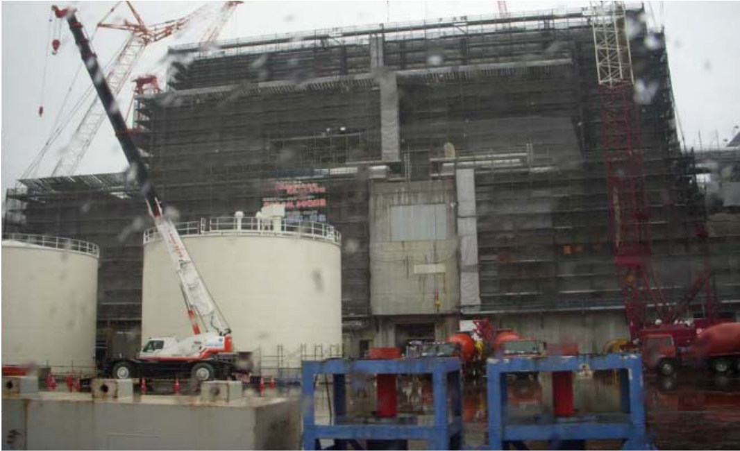
照片二 島根三號機反應器廠房
