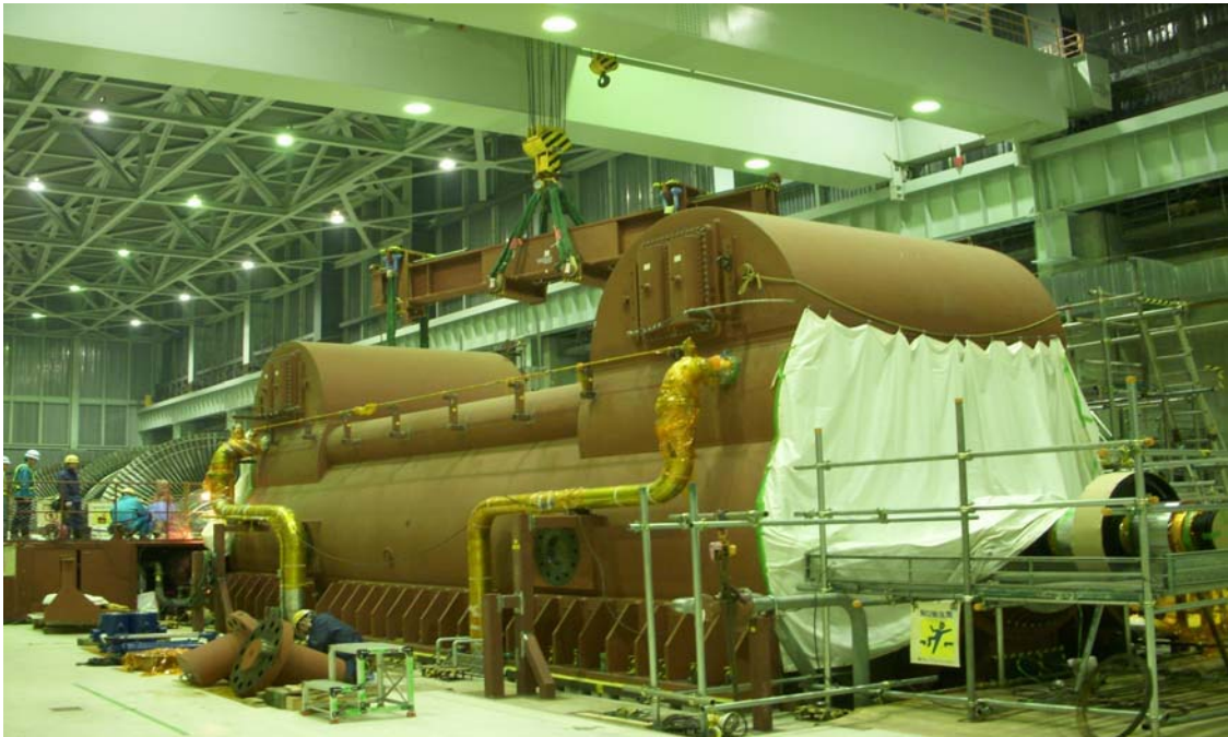
照片三 島根三號機汽機及發電機安裝現況
