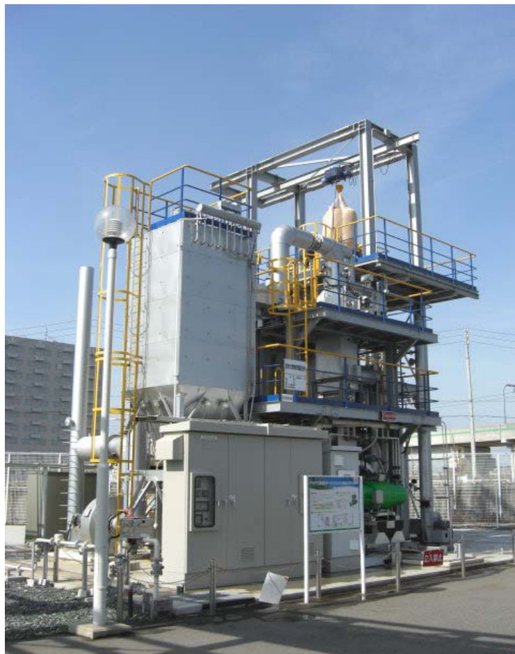
圖 7、日進料 4 噸之生質物利用 Stirling 引擎發電系統
