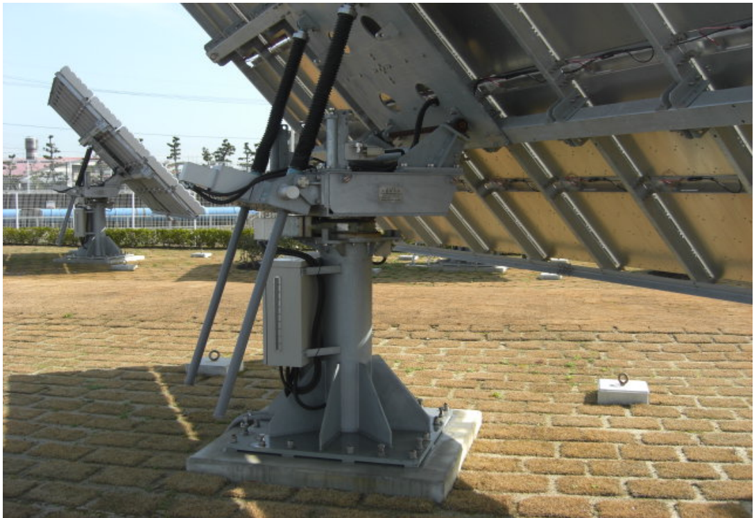
圖 5、高聚光(HCPV)系統控制系統
