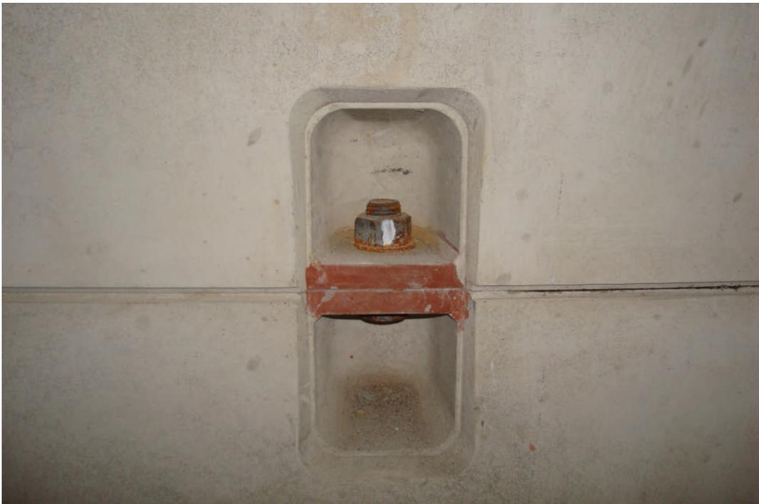
照片 2.2.6.2-5 潛盾隧道環片接頭(同環為螺栓接頭)
