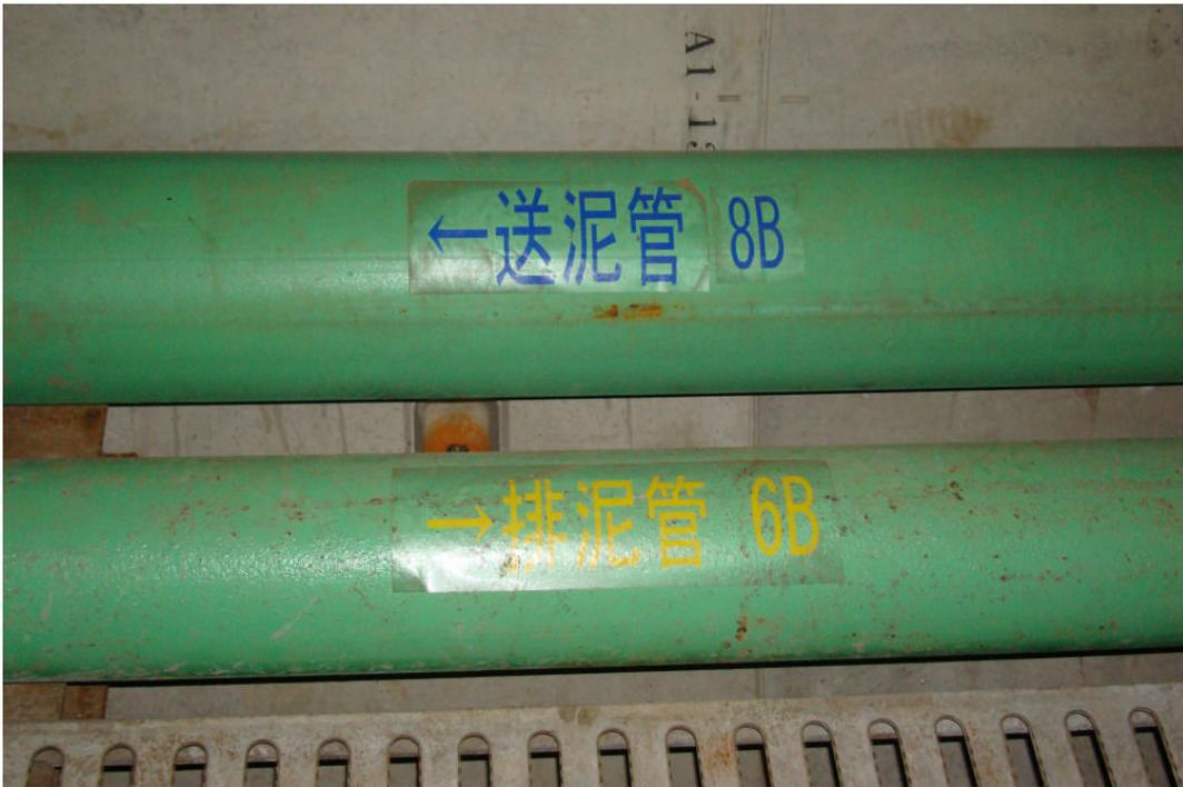
照片 2.2.6.2-6 潛盾隧道泥水管(排泥需較高流速管徑較小)
