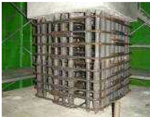
圖 2.2.4.3-5 傳統預鑄柱筋與基礎預留筋續接器連接示意圖
