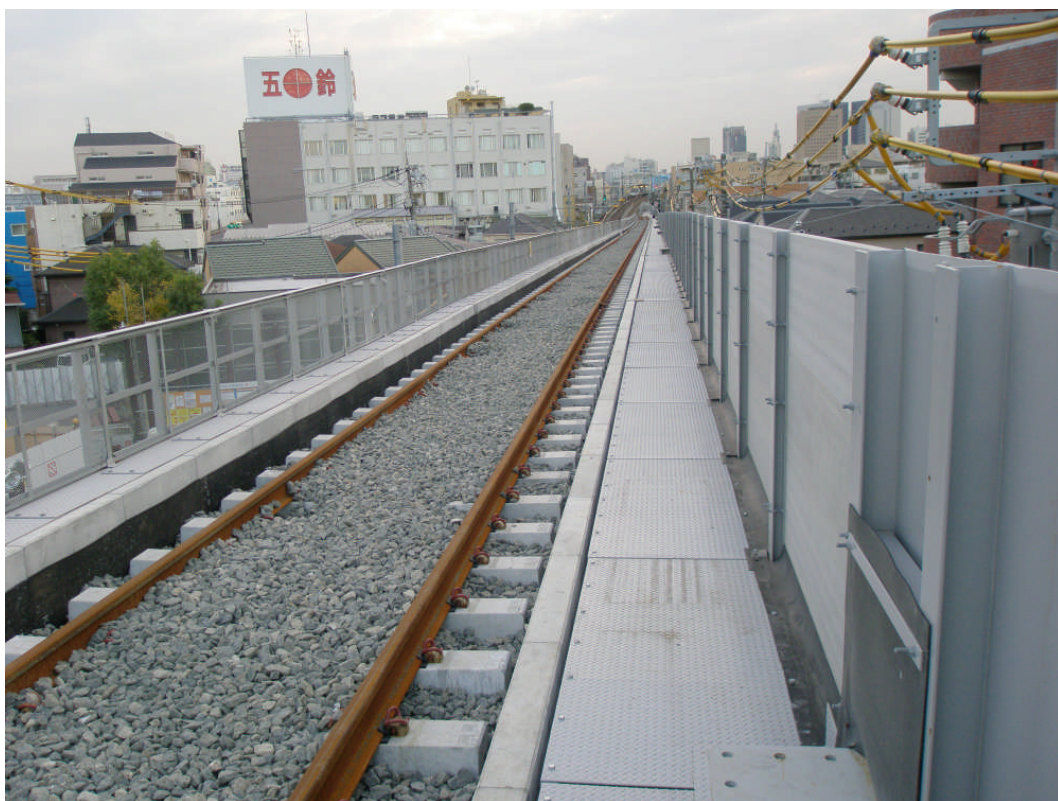
照片 2.2.4.2-9 切換用臨時軌採用傳統道碴軌道
