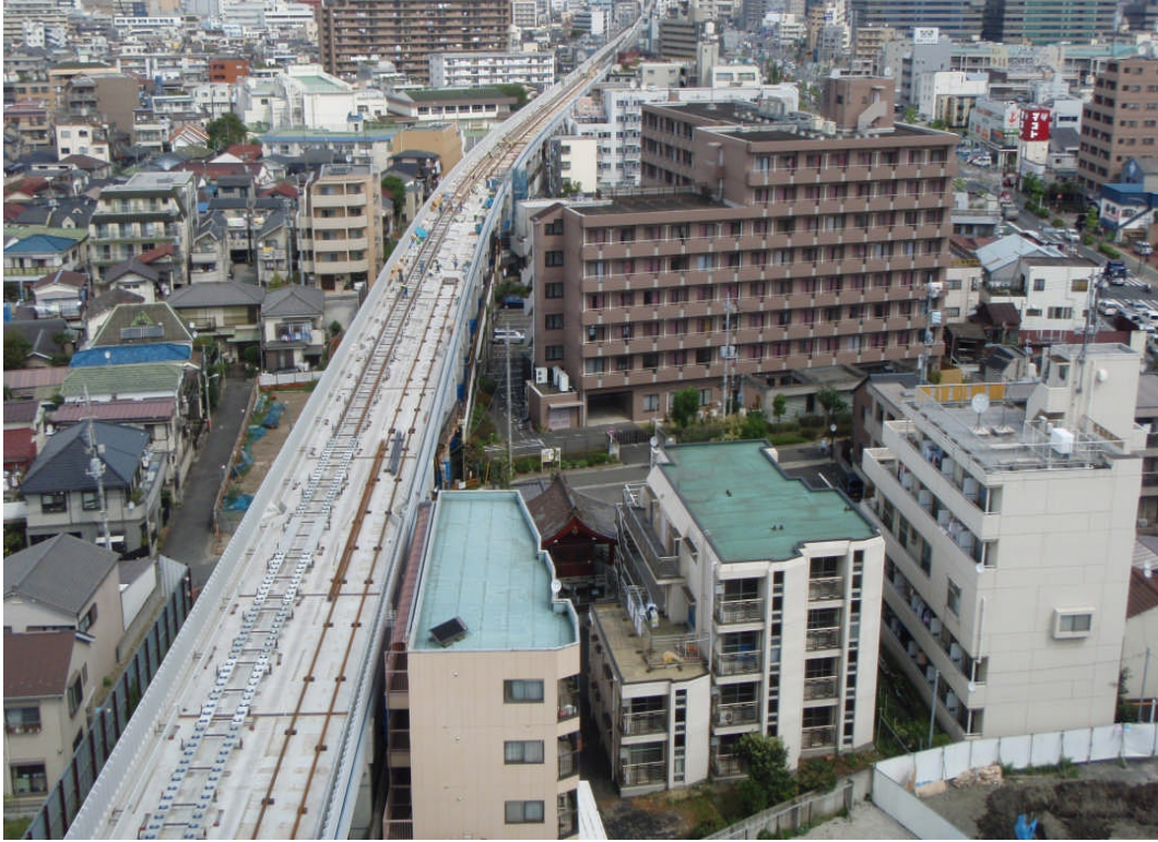
照片 2.2.4.2-10 高架橋完成後之鋪軌情景
