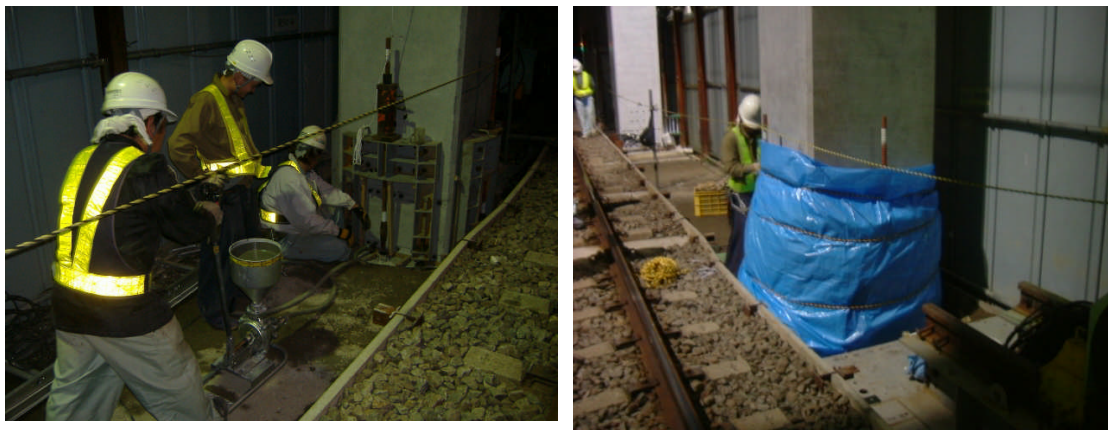
圖 2.2.4.3-8 預鑄柱不收縮水泥砂漿灌注及養生(電熱毯)
