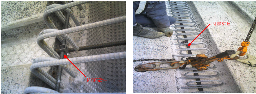
圖 2.2.4.3-12 版、梁接頭及版、板接合假固定
