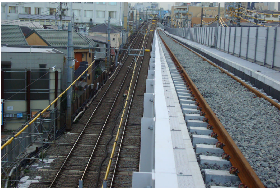
照片 2.2.4.2-8 現有軌及切換用臨時軌(爬升引道段)
