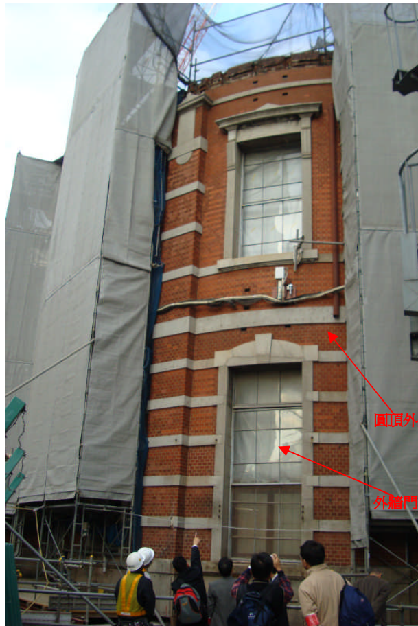
照片 2.2.5.2-5 丸之內站體復原現況(南側圓頂外觀)
