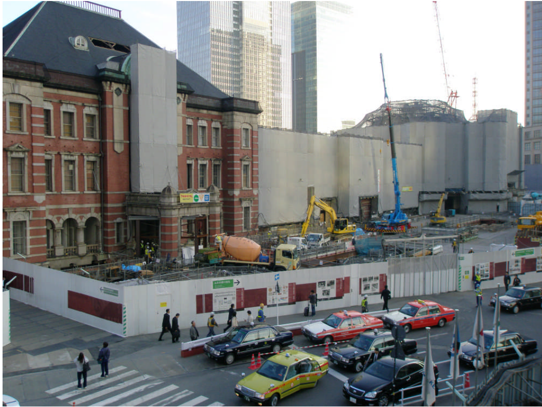
照片 2.2.5.2-1 丸之內站體復原現況(中央出入口及南側圓頂)
