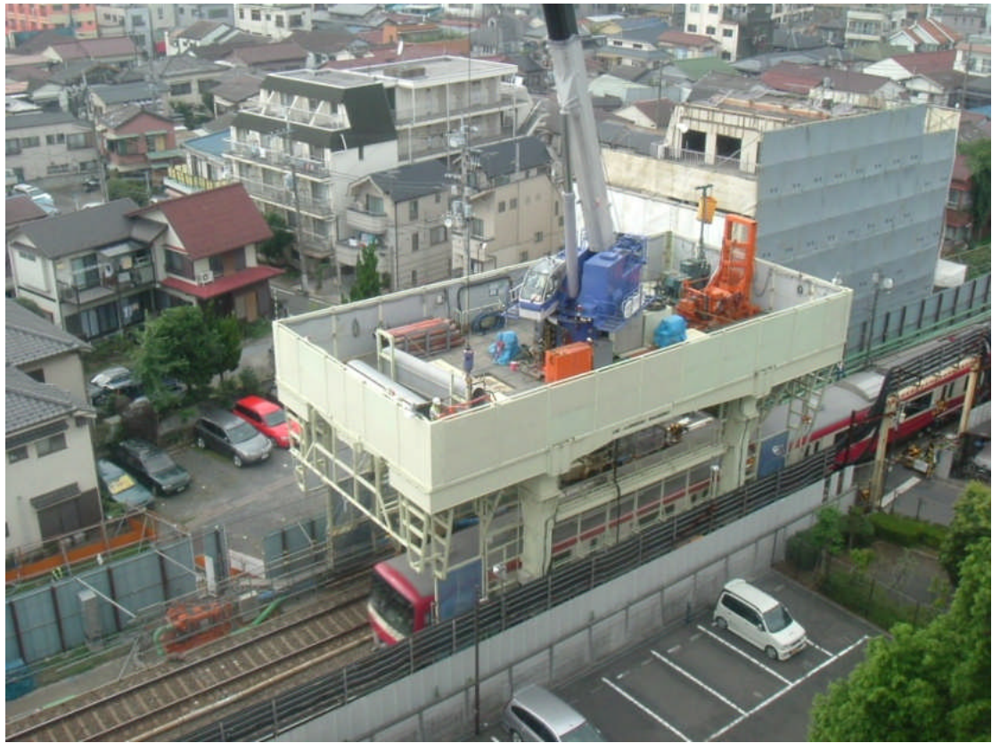
圖 2.2.4.3-2 直接高架施工機(樁基礎)
