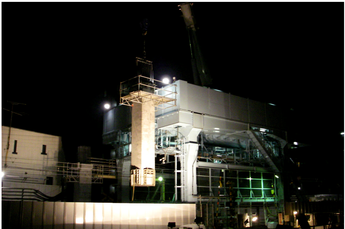
圖 2.2.4.3-3 直接高架施工機(吊裝機)
