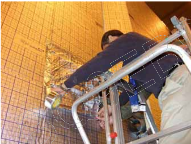
圖四十七：將隔間牆表面鋁箔撕下
