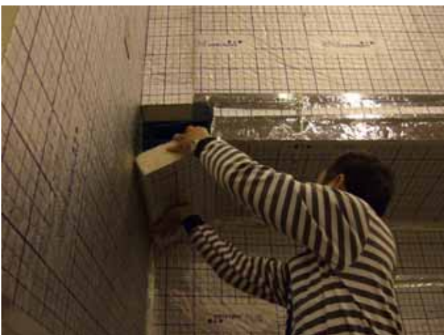
圖四十九：管線不規則區域填補
