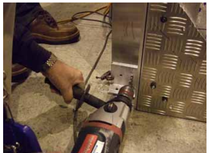
圖五十：門柱固定
