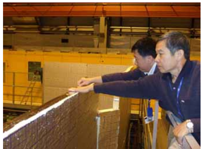
圖四十六：黏貼隔間牆頂端鋁箔膠帶
