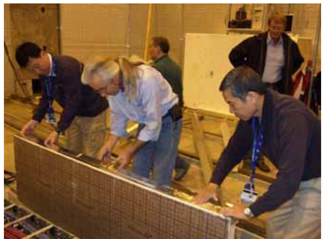
圖四十二：輕隔間鋁箔膠帶黏貼工作
