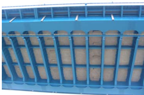
圖 6：跨海大橋橋面由 2 箱梁與隔梁組成
