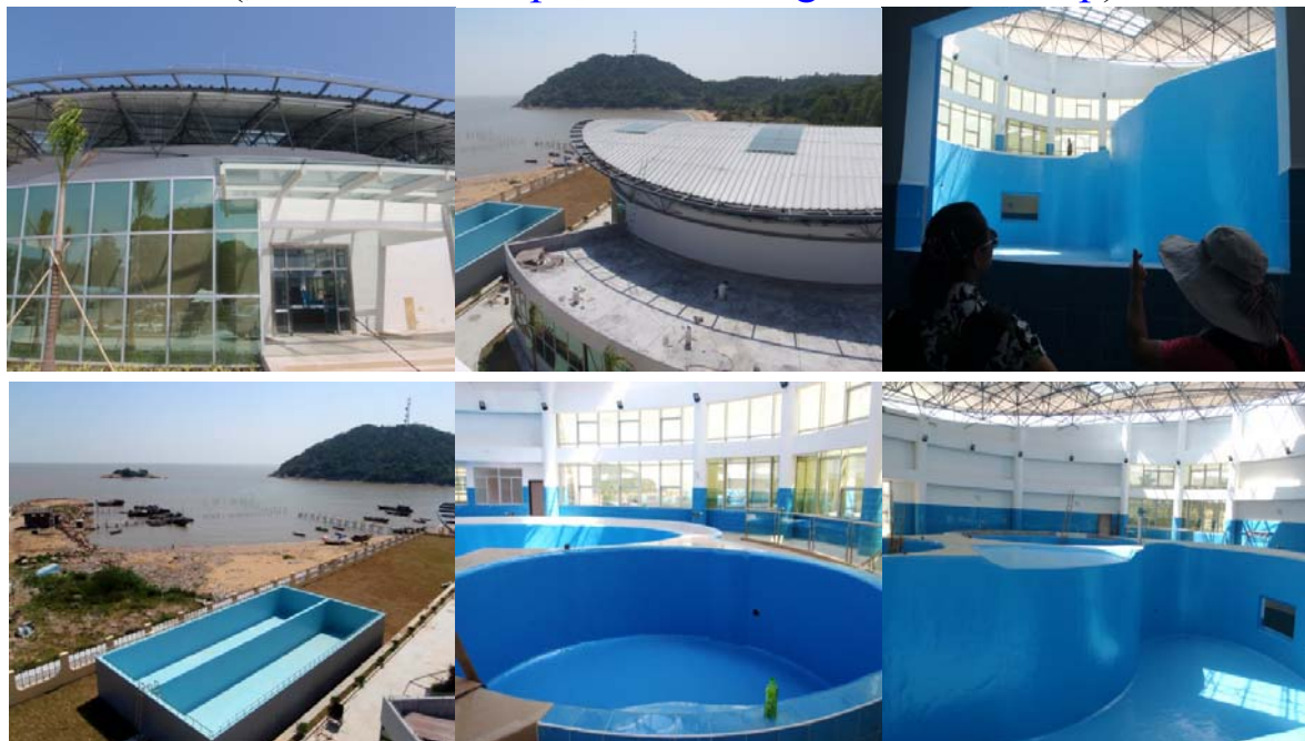
圖 2-9 保護區行政管護基地建設現況
