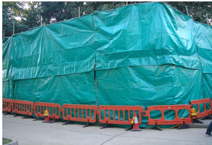
圖 3-20 內有挖土機施工
