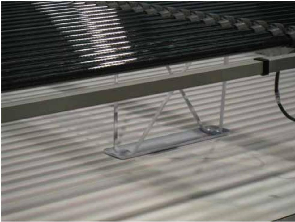
圖十四 比傳統太陽模組更輕巧的安裝支架
