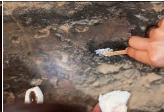
圖三十三 清潔示範區：塗敷 3) Belfor SRF 2NA，移除被溶解的煙燻。
