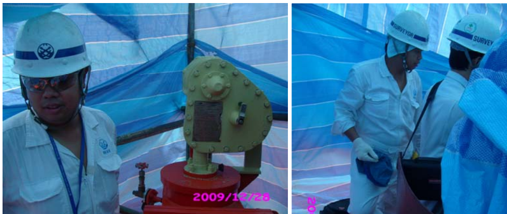
(圖五) 浮筒式液位錶鉛封
