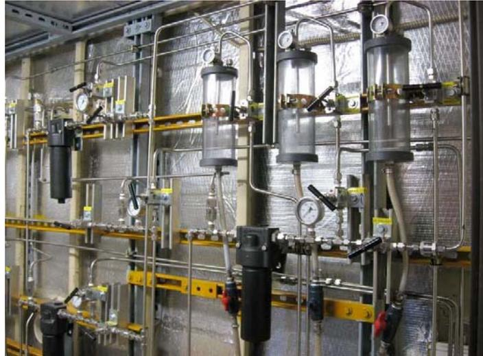
圖 34 多層次 U-tube 地球化學取樣系統可提供 CO<sub>2</sub> 分佈與示蹤劑抵達的資訊
