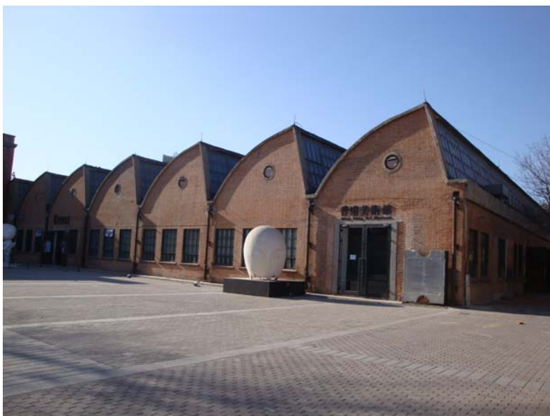
(半弧形採光型式的連棟廠房)
