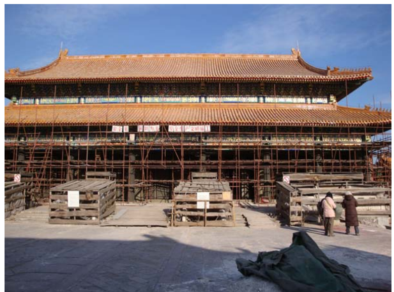
(慈寧宮修復現況外觀)
