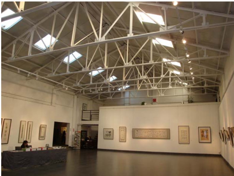
(工廠鋼桁架型式依然保存良好)
