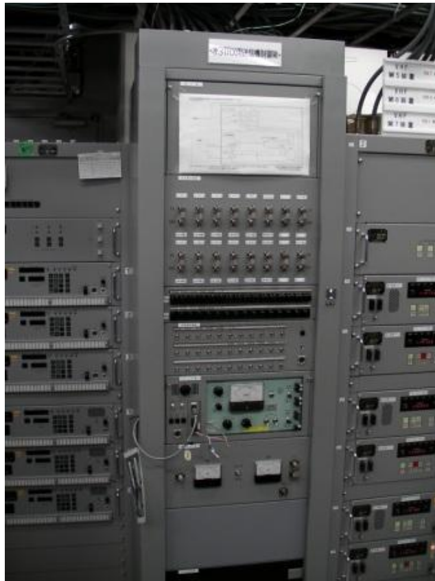
圖 83、無線電發射機控制器
