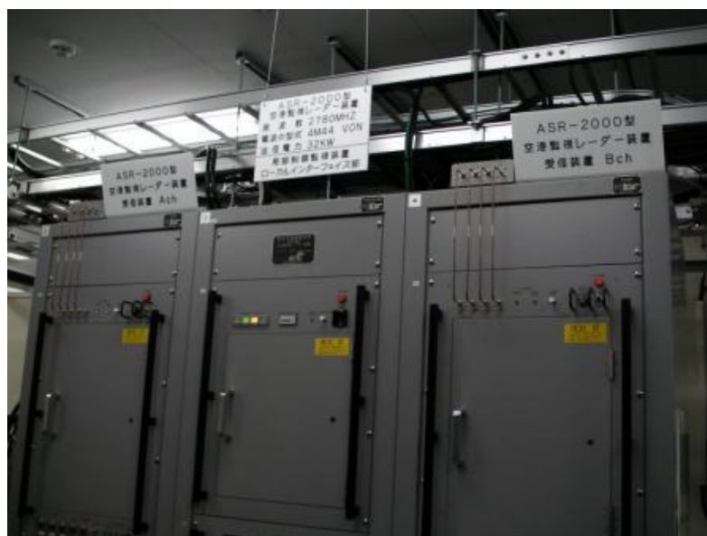
圖 64、A SR -2000 初級雷達接收處理器（雙機）
