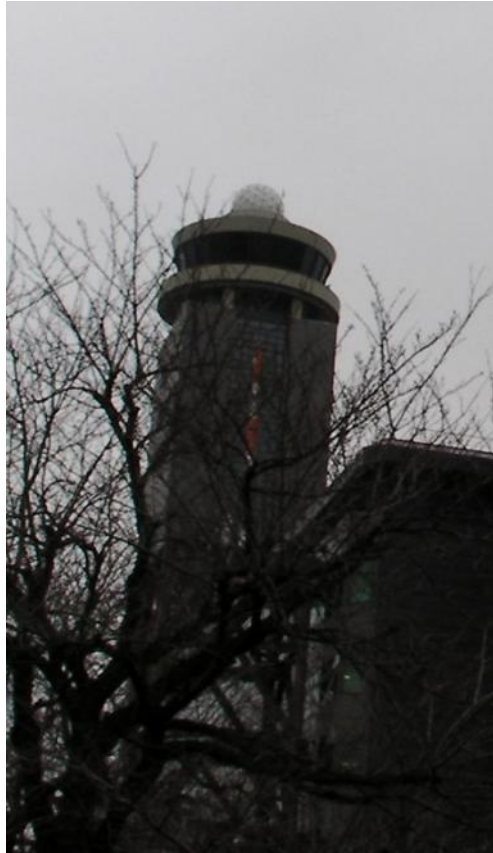
圖 35、塔臺屋頂的場面搜索雷達
