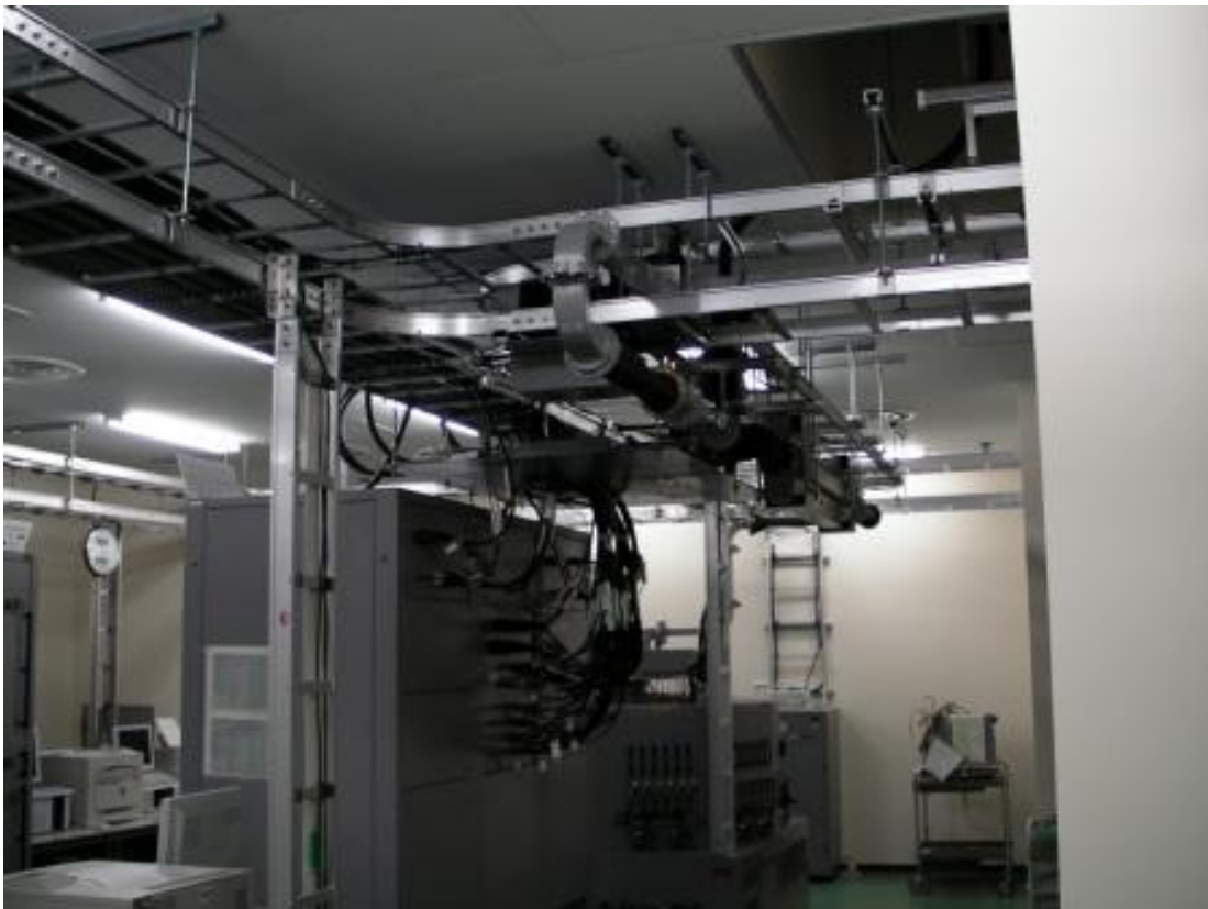
圖 68、導波管及線路配置
