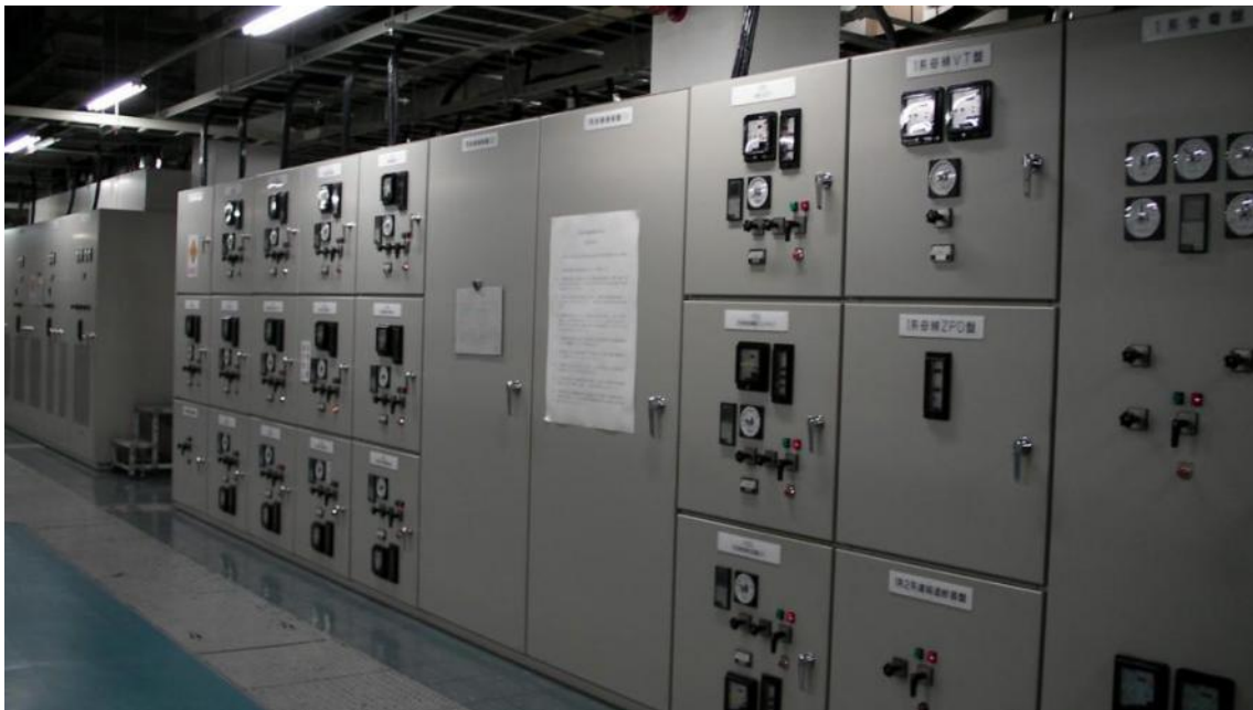
圖 24、高壓配電盤
