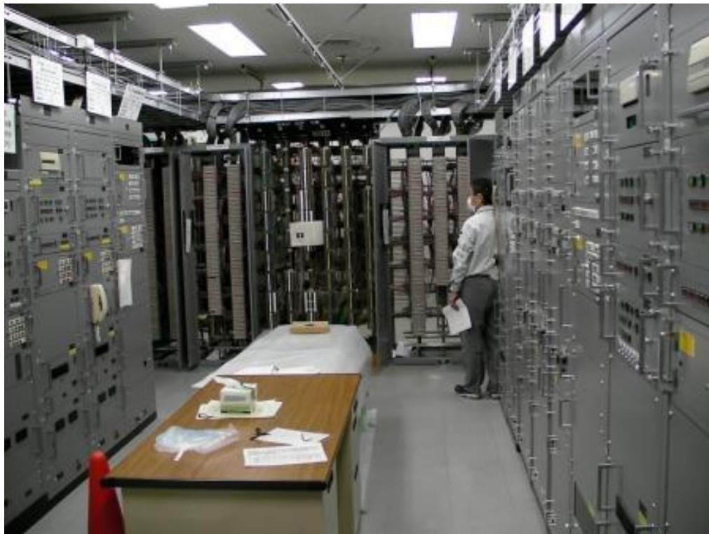
圖 85、配線架設置
