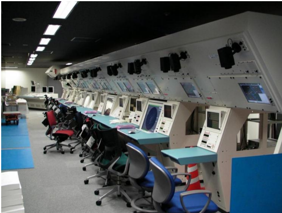
圖 54、架設中的成田機場近場管制席位
