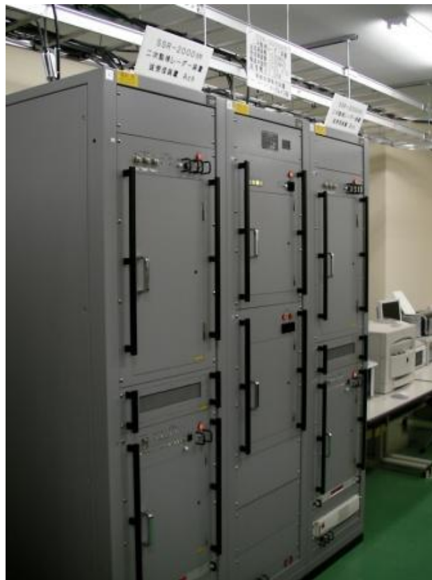
圖 66、SSR-2000 次級雷達收發機（雙機）
