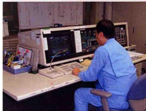
圖 29、空調系統監控端
