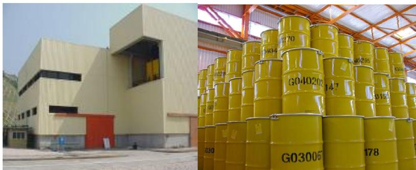
圖 5 核電站廢物暫存庫 QS(400L 鋼桶)
