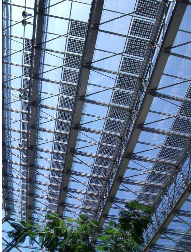
圖33 中庭採用溫室屋頂玻璃，設置太陽光電模組
