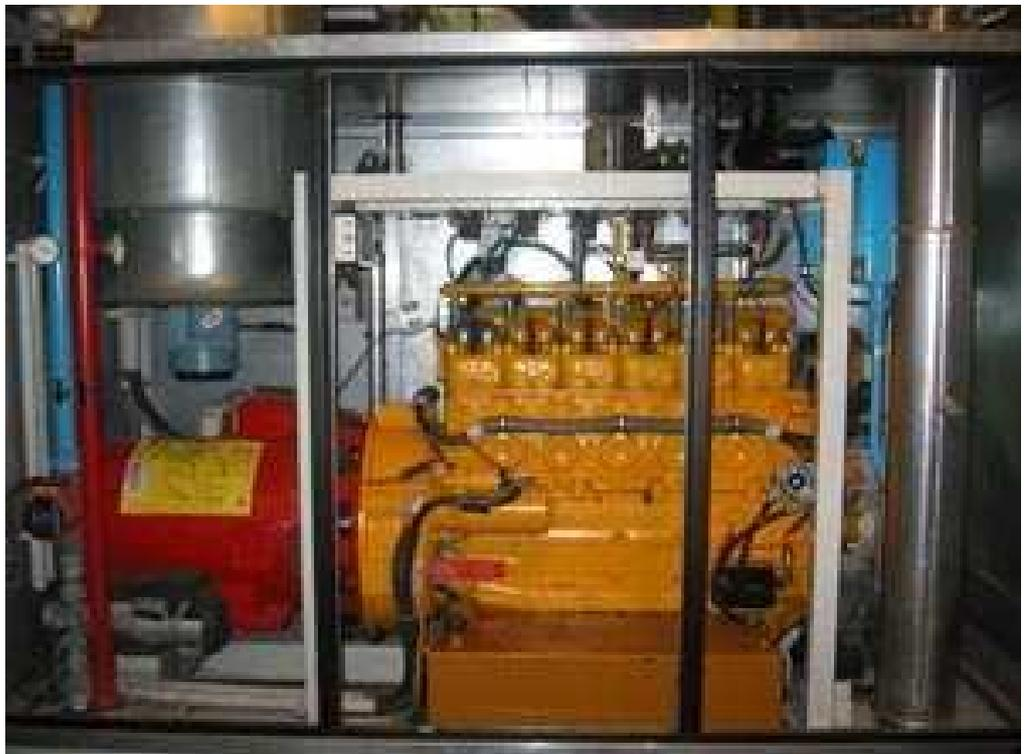
圖16 電腦化控制熱電整合系統
