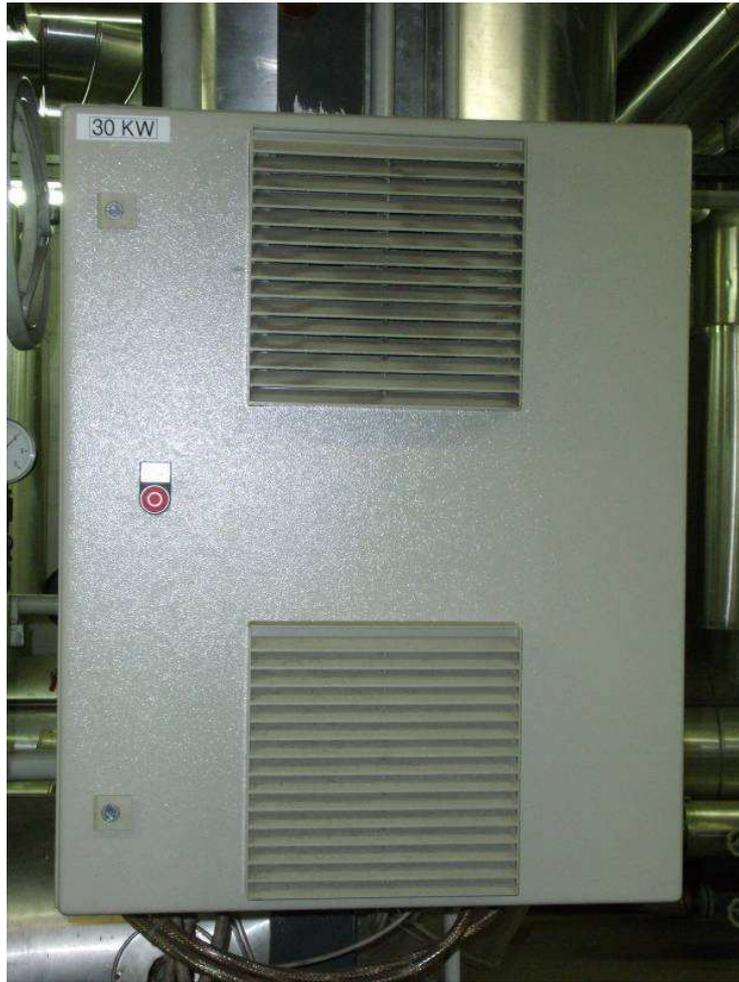
圖 40 泵浦及空調箱風機，採用變頻器控制轉速
