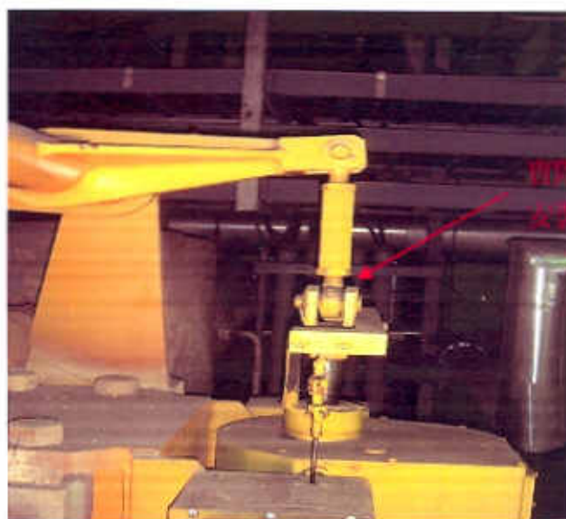
圖 12. EG3P 液壓驅動器現場安裝圖
