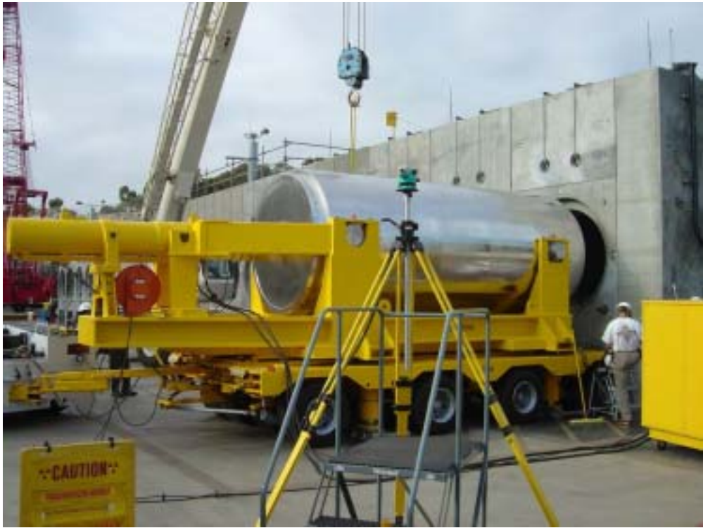
圖六：TN-24 護箱裝載作業
