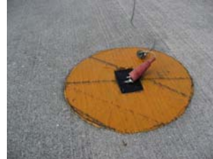
加油作業依規定實施並有接地
