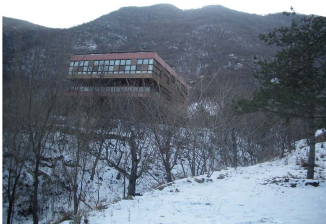
大陸建築師安東為「長城腳下的公社」設計的作品--「紅房子」(以自然且簡單的材料，混凝土、水泥紅磚、木頭、竹子、玻璃等建造而成)
