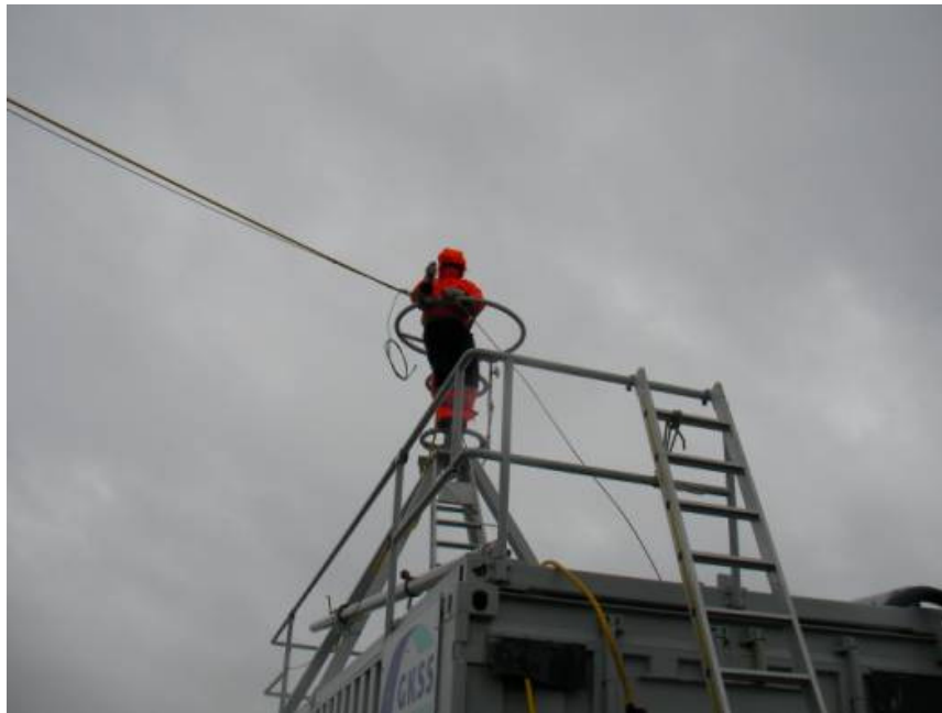
圖 41 電攬線檢查(比蘇姆岸基雷達觀測站)
