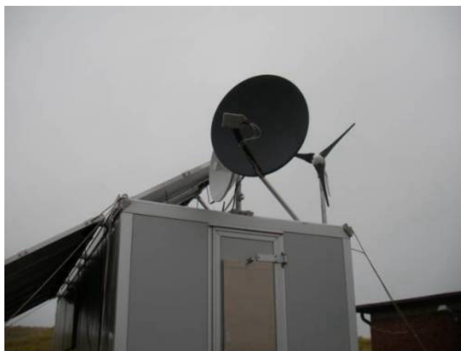
圖 28 List 北端岸基雷達站資料傳輸系統
