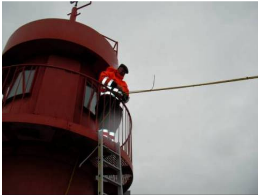
圖 45 燈塔端電攬線束帶更新
