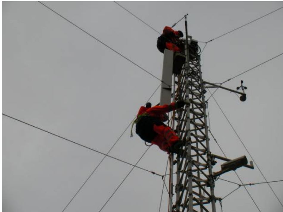
圖 50 List 南側岸基雷達本體拆解(1)
