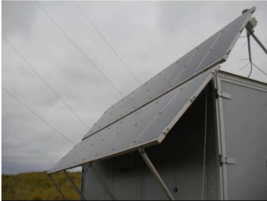
圖 25 List 南端岸基雷達拖車工作站房太陽能板
