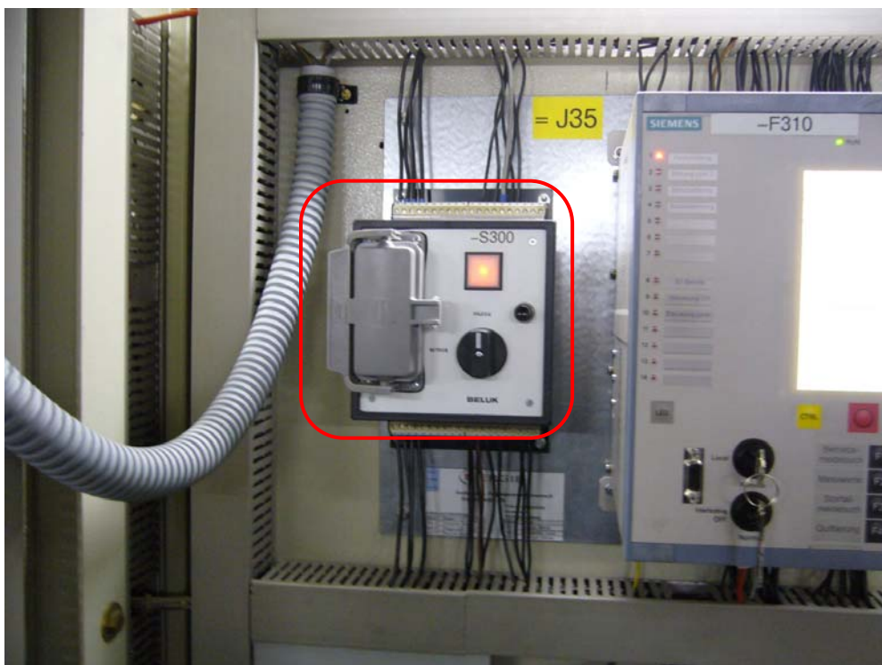
圖 23：中壓 IED 電驛測試開關
