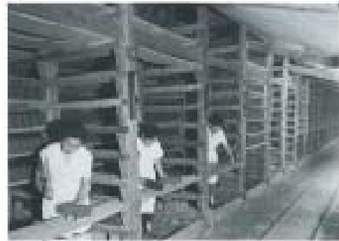
窯地仕上げ作業
