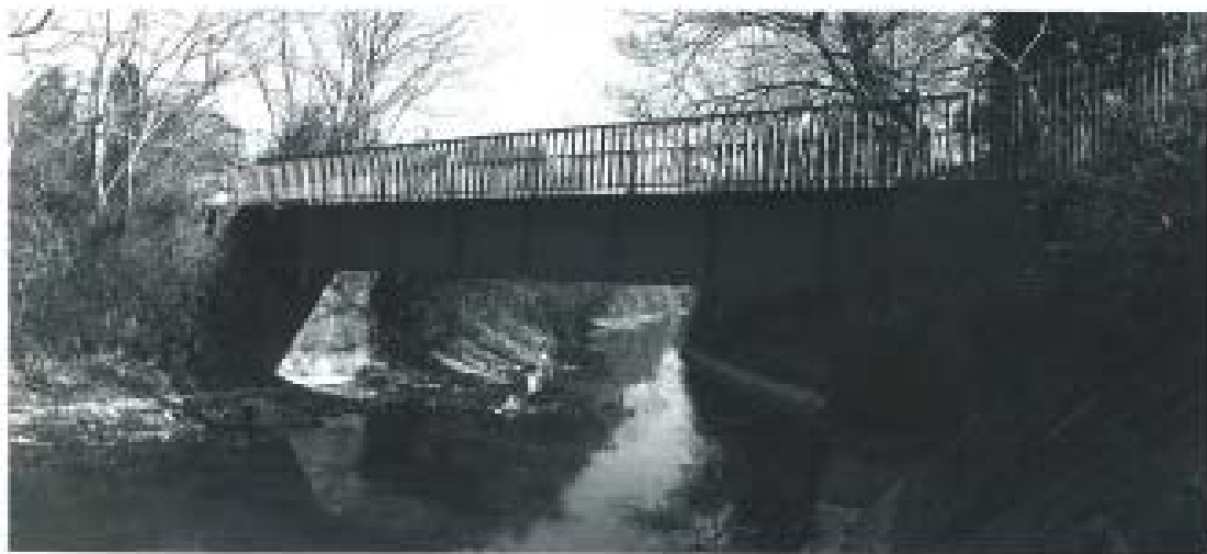
備前渠鉄橋現況
