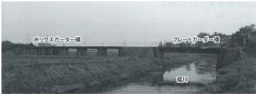
河川改修以前の福川鉄橋
