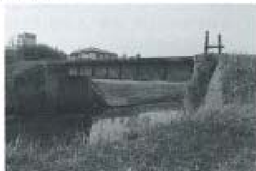
プレートガードー橋
