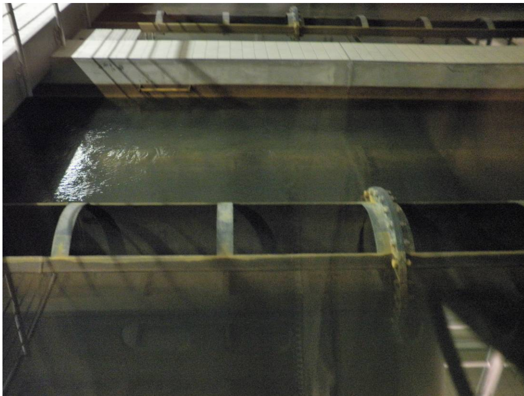
圖 21 反洗排水渠採用圓管切渠
