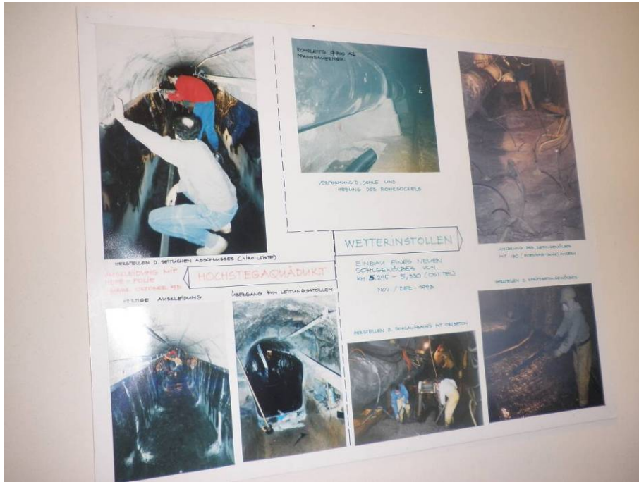
圖 14 自來水導水渠道施工及維護照片
