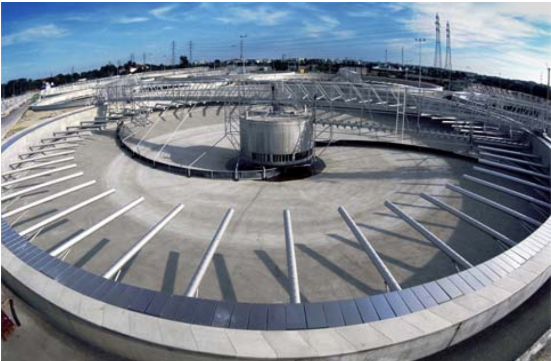
終沉池(其構造及設計非常特別,底部爲刮泥板,表面設置螺旋刮渣,圖出部分爲集水管)(13)
