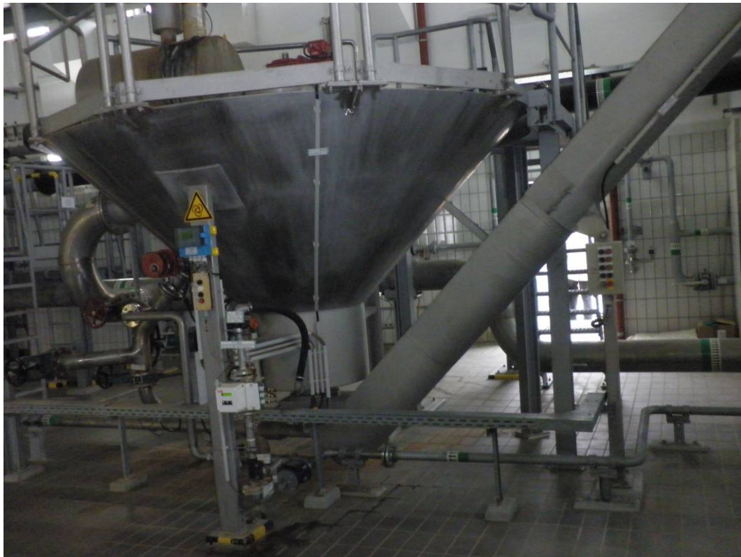
圖 24 利用密閉系統處理細篩及砂礫槽之廢氣
