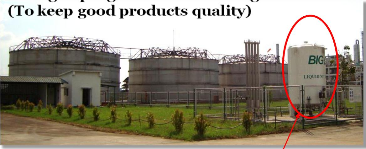
EPC 有 3 個 4,000 KL 不鏽鋼製造的酒精成品儲槽
