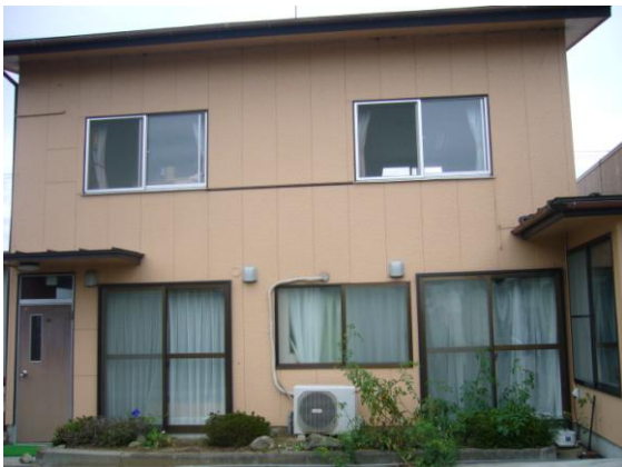
圖 5-13 一樓為日間照顧中心、團體家屋，二樓則為居家支援中心
