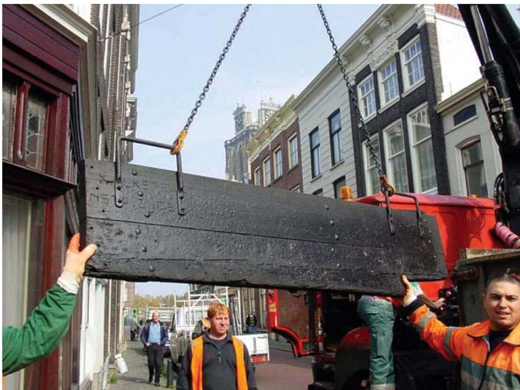
圖 4-5 擋水吊裝情形
