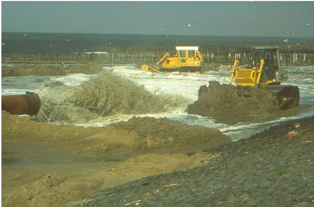
圖 3-22 海砂補償工程（二）
