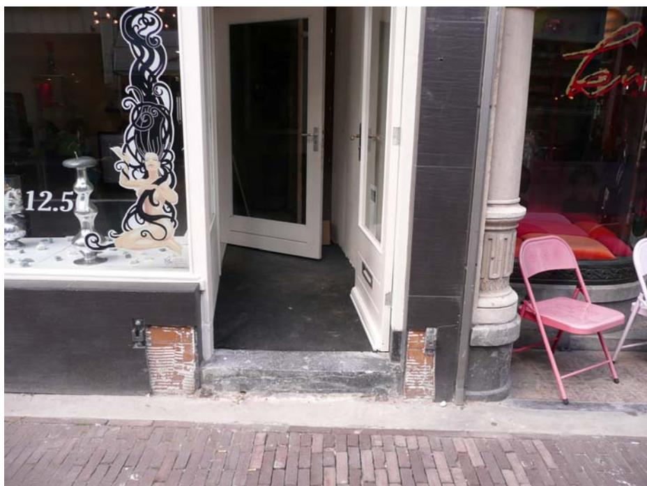
圖 4-12 房屋門口擋水版插槽
