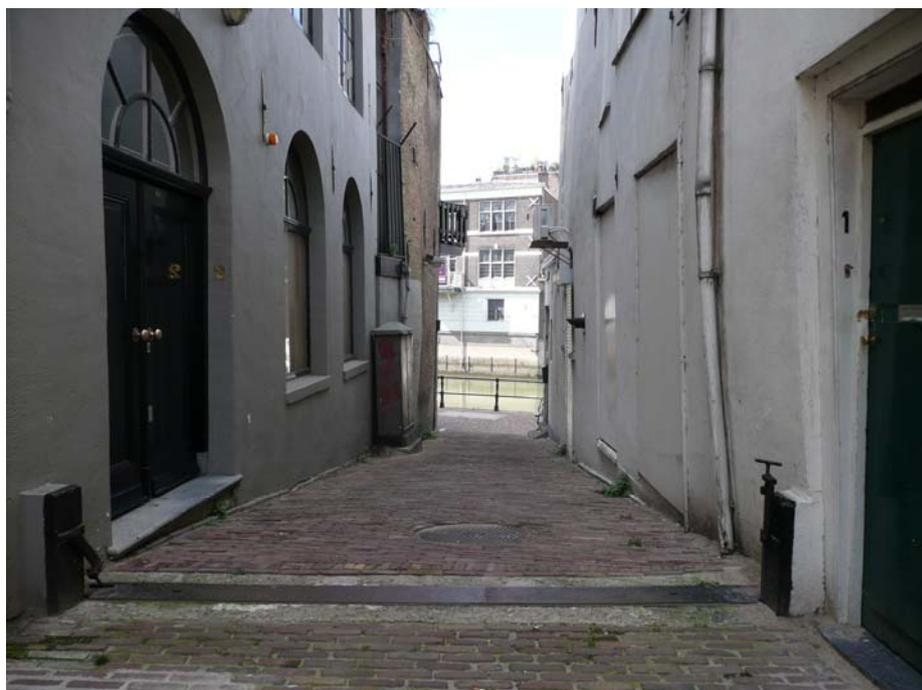
圖 4-13 巷弄水位操作擋水版插槽
