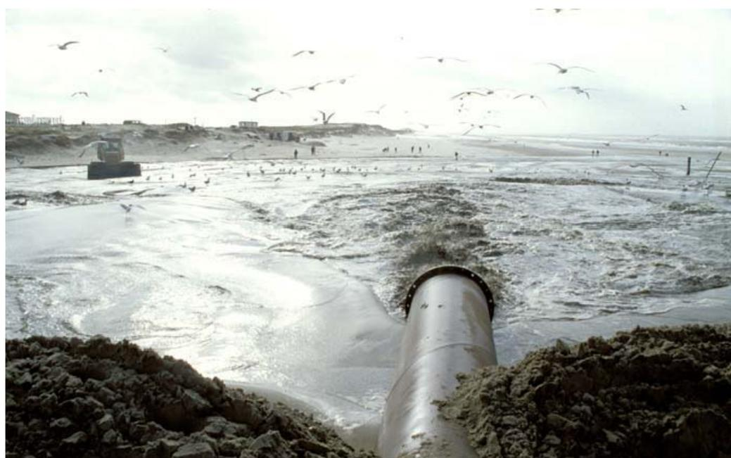
圖 3-21 海砂補償工程（一）
