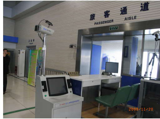
圖 36 旅客通道檢查設備
